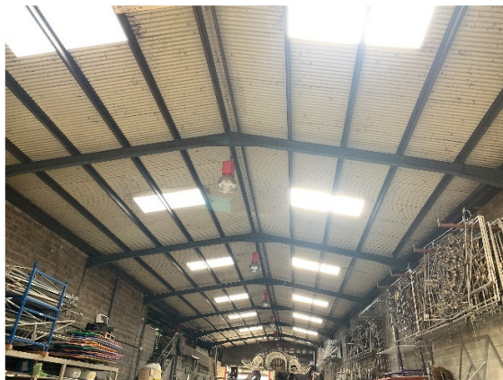
Estructura de la coberta del cos principal (27.03.23)
