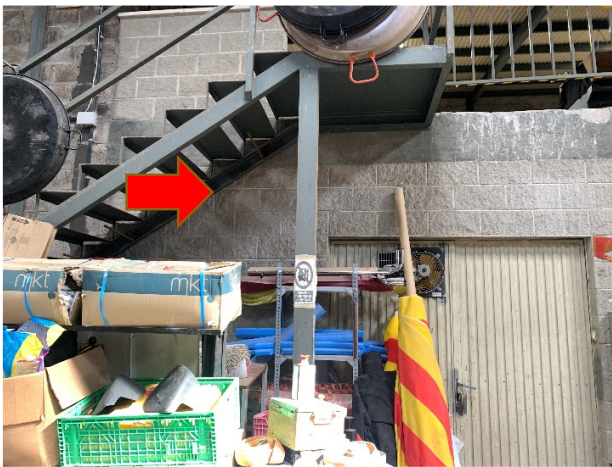
Ubicació dels 2 inversors, quadre CC, quadre CA i caixa de seccionament de terra.
