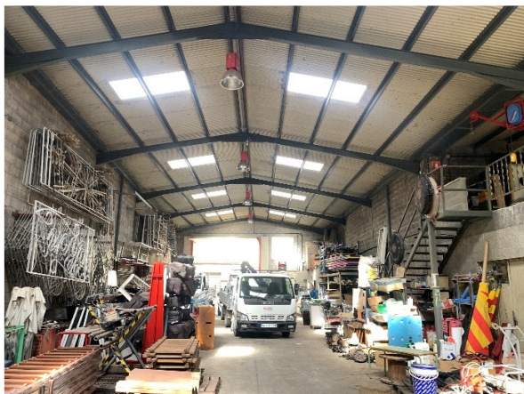
Estructura portant de la coberta.
