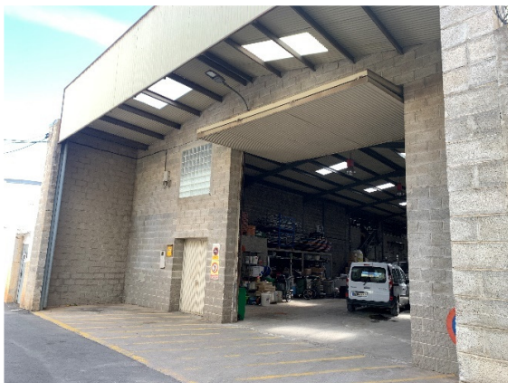
Accés principal del magatzem municipal (27.03.23)
