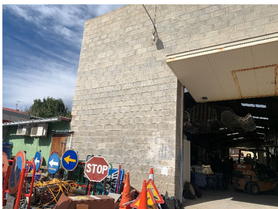
Accés posterior del magatzem i façana on s'ubicarà l'escala exterior(27.03.23)
