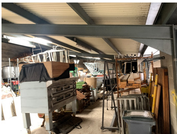
Estructura de la coberta des de l'altell (27.03.23)
