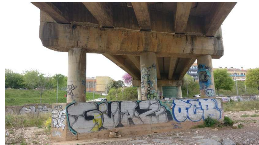
Figura 5. Vista de pila central
