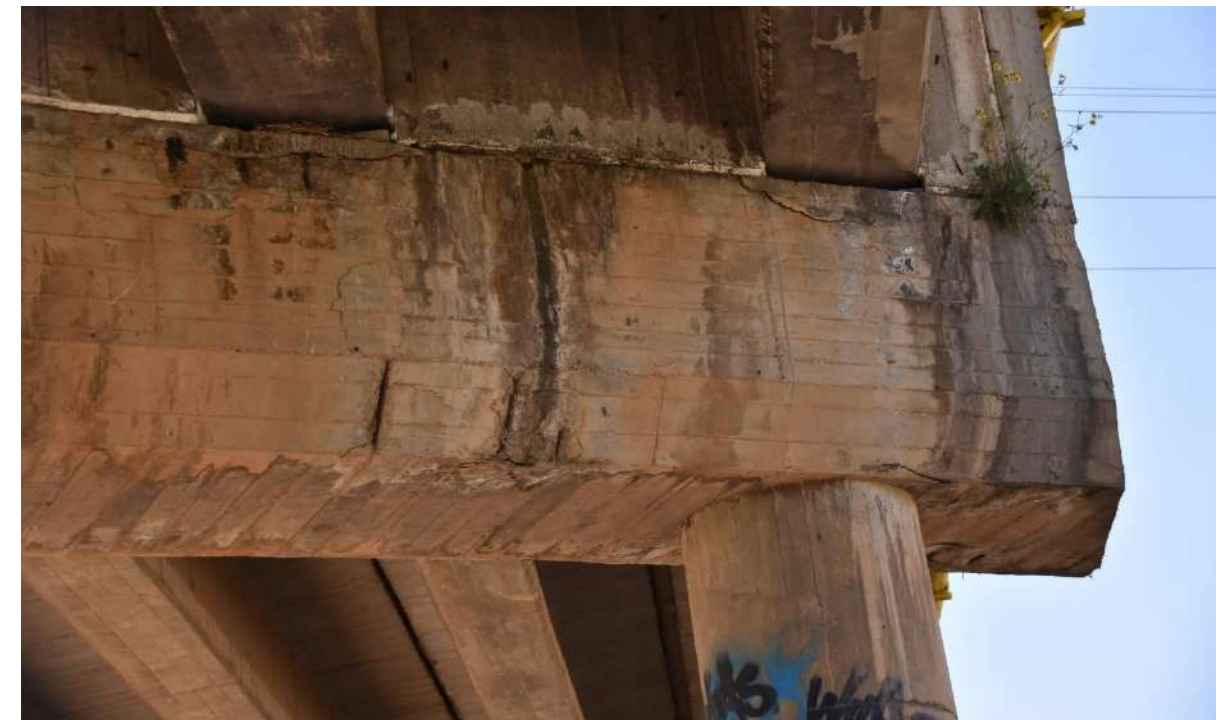
Figura 4. Detall de l'estat de les piles
