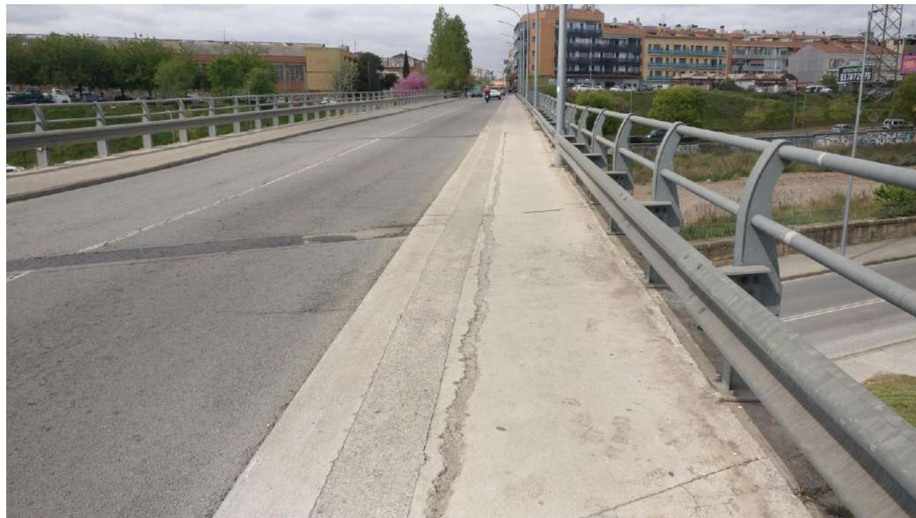
Figura 5. Vista de plataforma actual des del costat est - vorera nord
