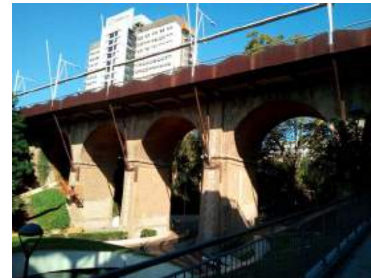
Fotografia 1.- Fotografia de l'alçat del pont existent
