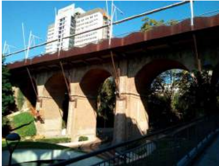
Fotografia 1.- Fotografia de l'alçat del pont existent
