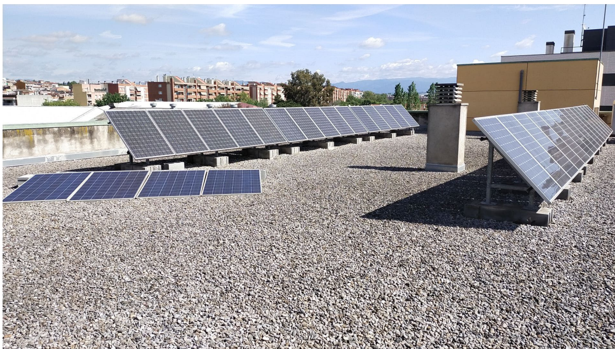
Il·lustració 3 Emplaçament de la instal·lació 3. Coberta plana (parcialment ocupada actualment)
