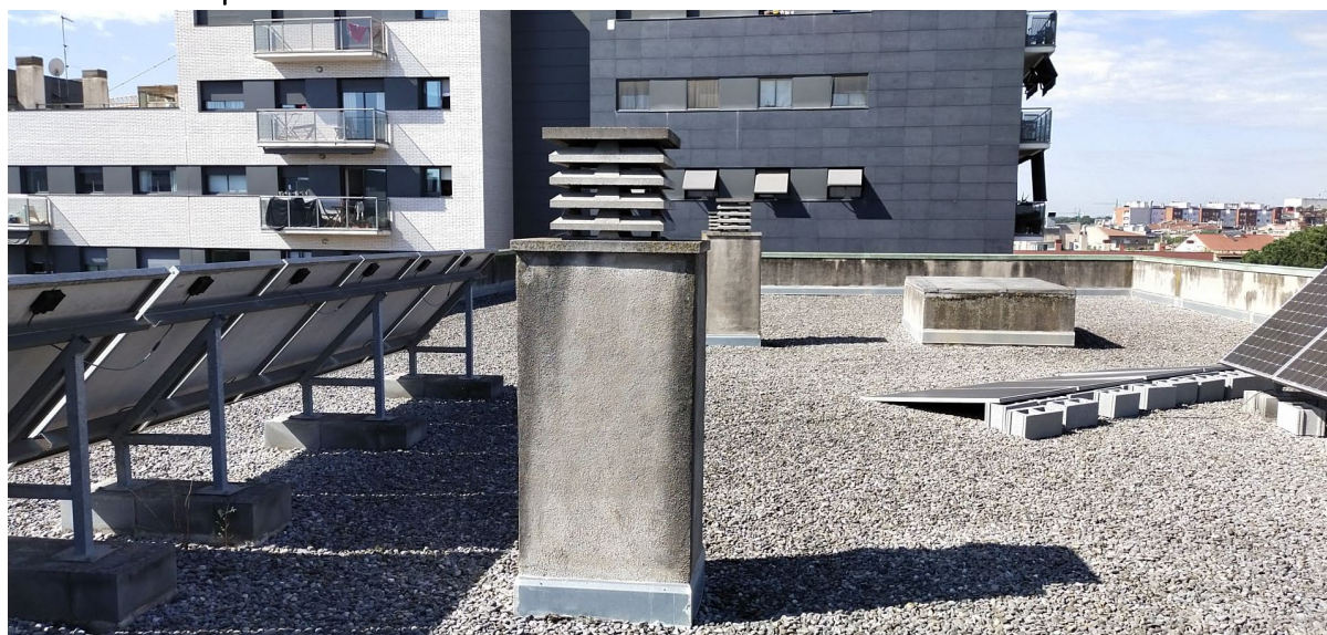
Il·lustració 6 Estat actual de coberta
