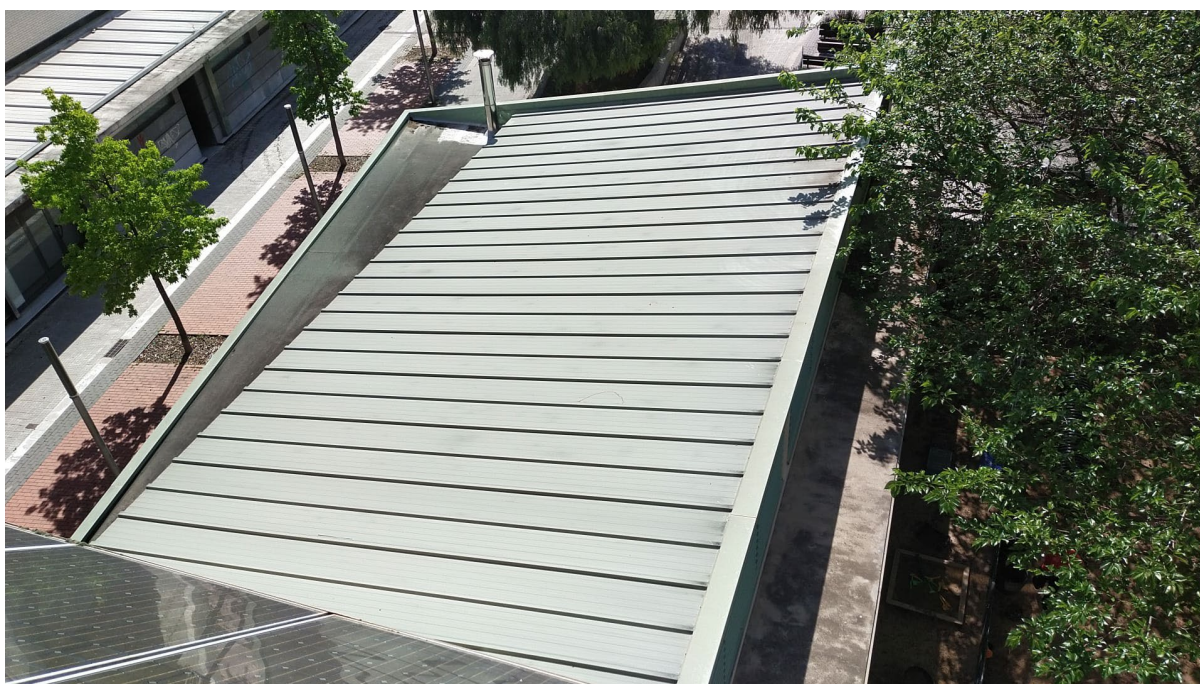
Il·lustració 4 Emplaçament de la instal·lació 4: Coberta de xapa
