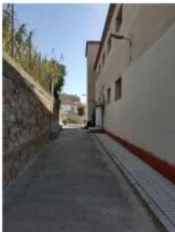
Foto 03. Passatge interior nord
