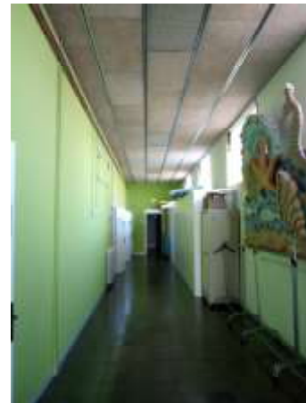
Foto 12. Corredor planta primera
