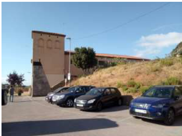
Foto 01. Centre Cívic des de l'aparcament
