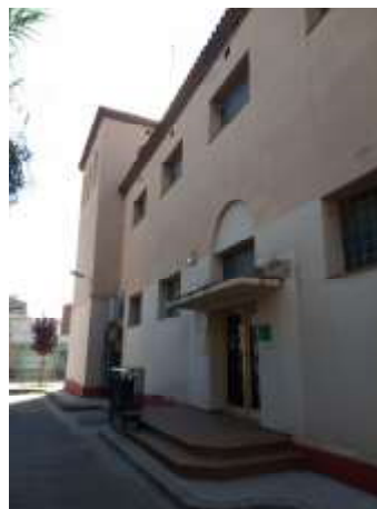
Foto 02. Passatge entrada principal nord
