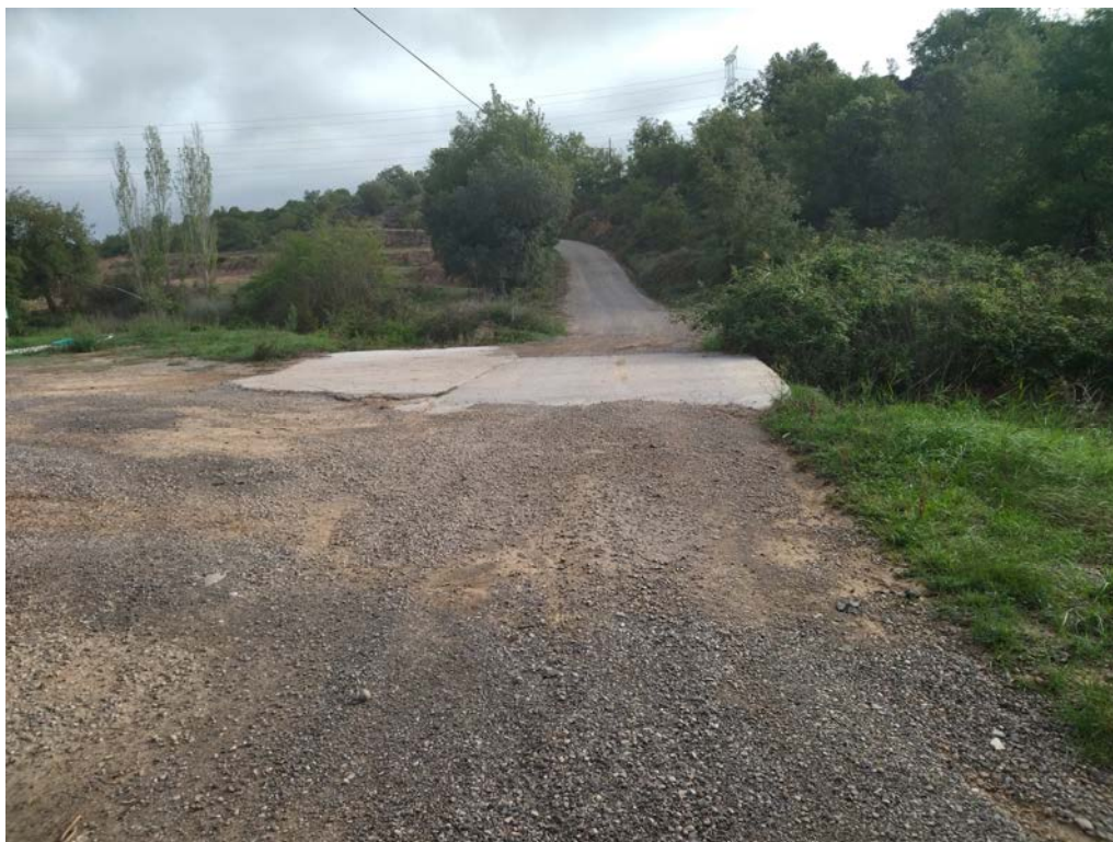
Punt final, entrega a paviment de formigó, pas Barranc de Granell
