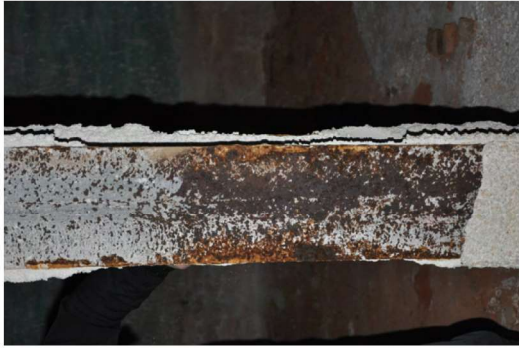
- Alguns pilars metàl·lics presenten desprendiments del revestiment ignífug per oxidació del material base.
