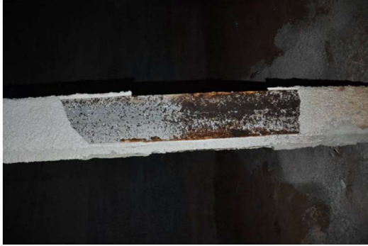
- Alguns pilars metàl·lics presenten desprendiments del revestiment ignífug per oxidació del material base.
