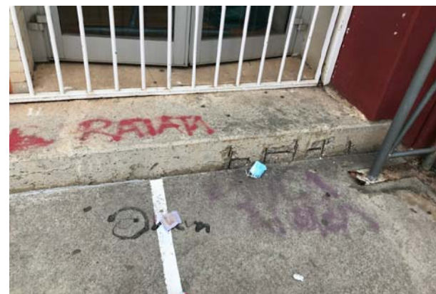
REPARACIÓ DE FORMIGONS ESTRUCTURALS.
