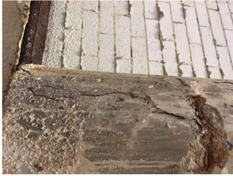
- Alguns pilars metàl·lics presenten desprendiments del revestiment ignífug per oxidació del material base.
