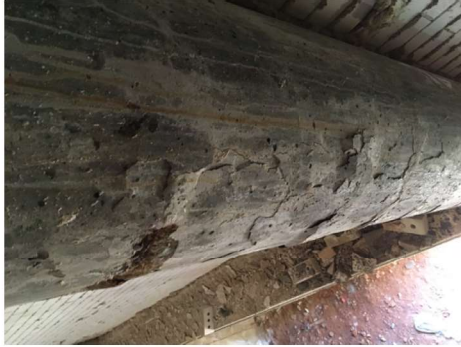
- Alguns pilars metàl·lics presenten desprendiments del revestiment ignífug per oxidació del material base.
