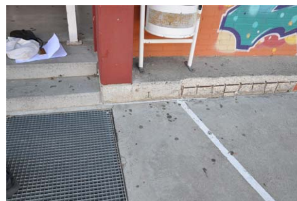
REPARACIÓ DE FORMIGONS ESTRUCTURALS.
