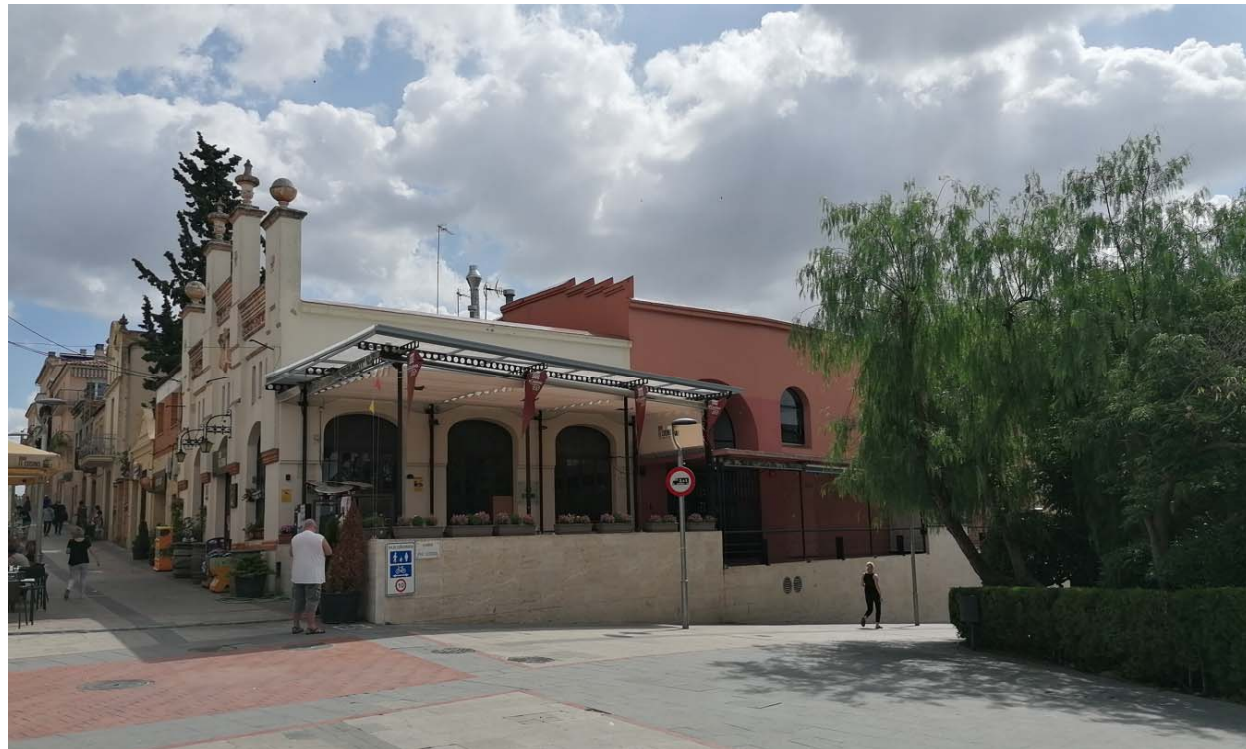
Vista del Casino des de la cruïlla entre el carrer Sant Joan i Pau Costas
