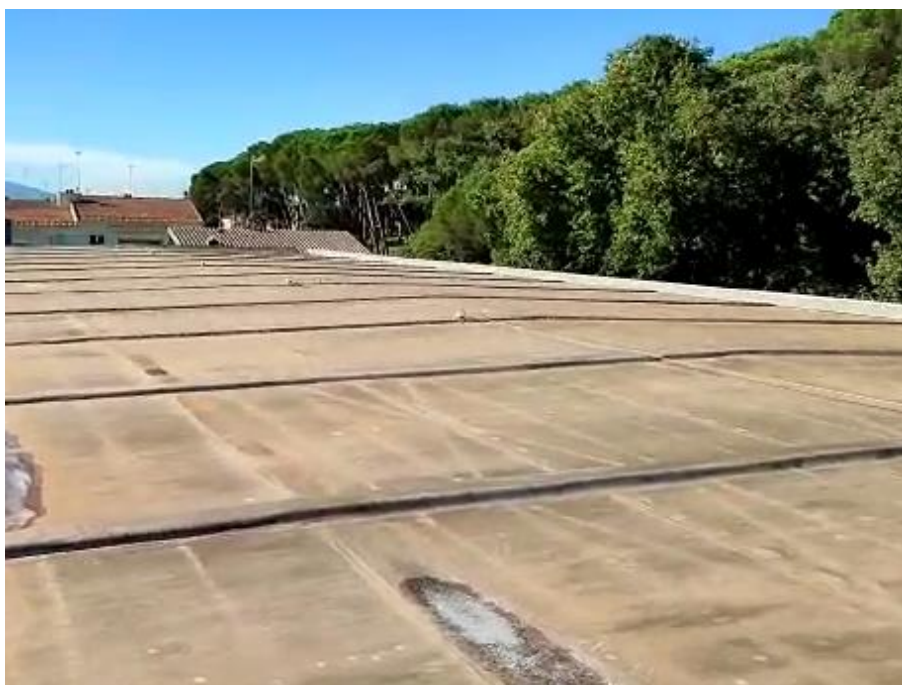
Imatge 16. Situació actual – coberta del edifici principal
