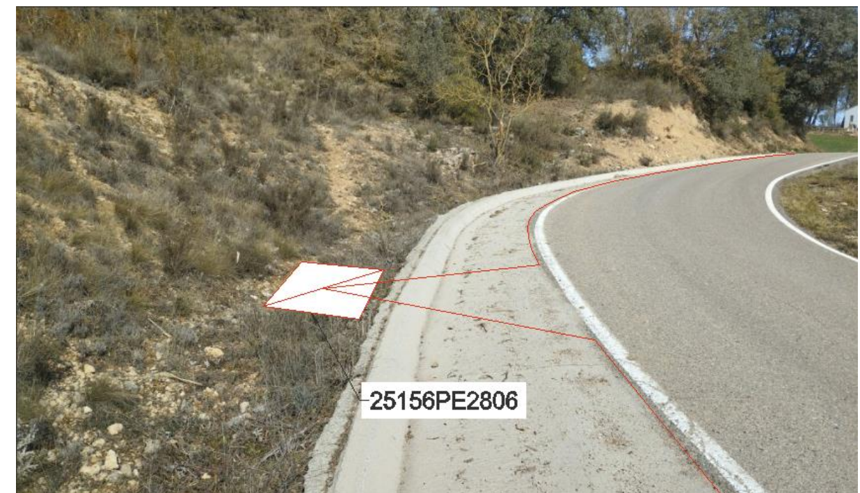
Fig 7. Nova microrasa del tipus 6c20 des del pericó en projecte (pericó tipus B2) 25156PE2806, fins al pericó en projecte (pericó tipus C2) 25037PE2800 (microrasa en formigó).
