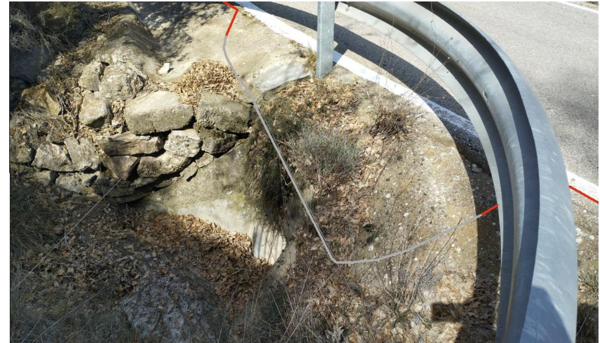
Fig 18. Nou tub metàl·lic de 1 conducte de \varnothing 90 mm (Subconductat 6 conductes de \varnothing 20 mm) des del canvi d'infraestructura 25037CI2812 fins al canvi d'infraestructura 25037PE2813.
