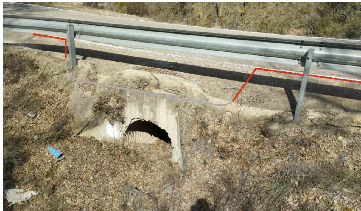
Fig 17. Nou tub metàl·lic de 1 conducte de \varnothing 90 mm (Subconductat 6 conductes de \varnothing 20 mm) des del canvi d'infraestructura 25037CI2810 fins al canvi d'infraestructura 25037PE2811.
