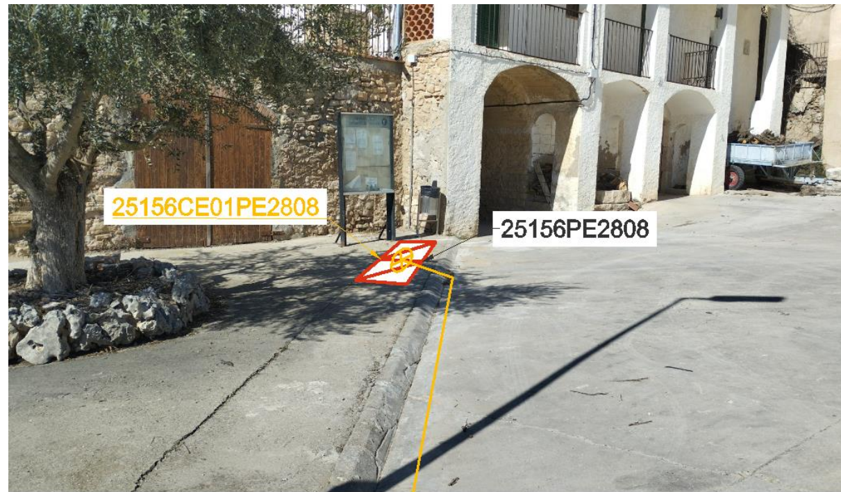
Fig 35. Instal·lació caixa d'empalmament 25156CE01PE2808.
