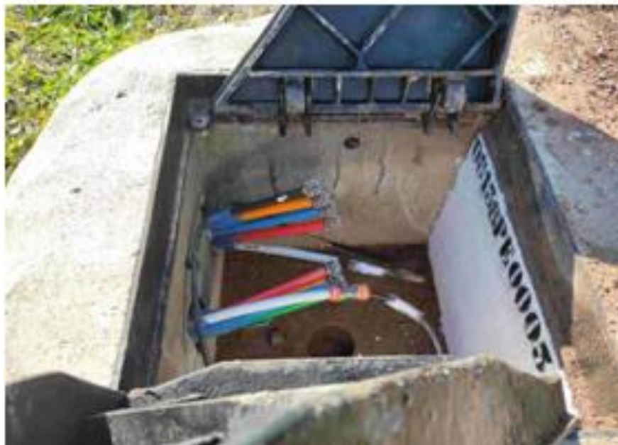
Exemple de tall dels microductes i taps d'obturgació
