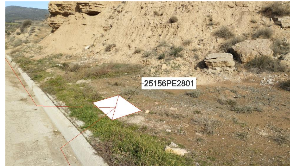
Fig 2. Nova microrasa del tipus 6c20 des del pericó en projecte (pericó tipus B2) 25156PE2801, fins al pericó en projecte (pericó tipus B2) 25156PE2802 (microrasa en formigó).
