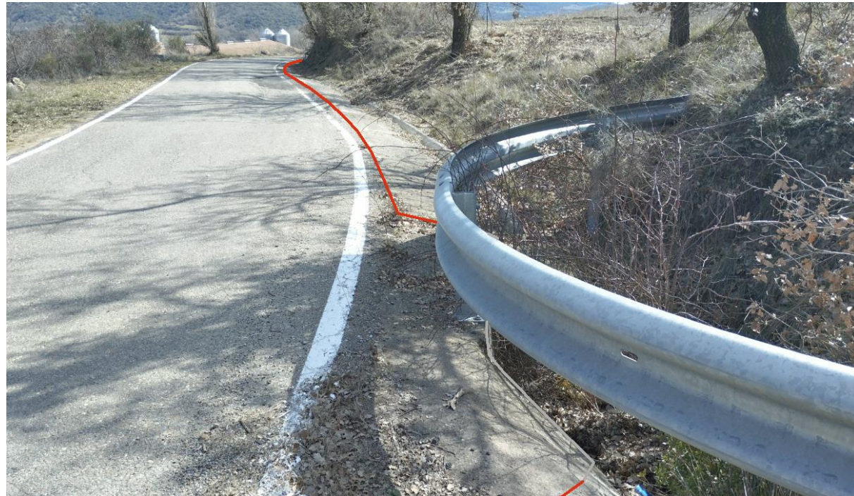
Fig 16. Nou tub metàl·lic de 1 conducte de \varnothing 90 mm (Subconductat 6 conductes de \varnothing 20 mm) des del canvi d'infraestructura 25037CI2808 fins al canvi d'infraestructura 25037PE2809.
