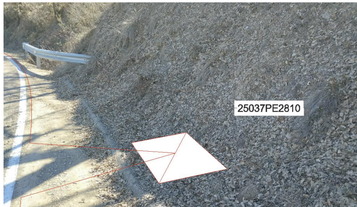
Fig 20. Nova microrasa del tipus 6c20 des del pericó en projecte (pericó tipus B2) 25037PE2810, fins al pericó en projecte (pericó tipus B2) 25037PE2811 (microrasa en formigó).
