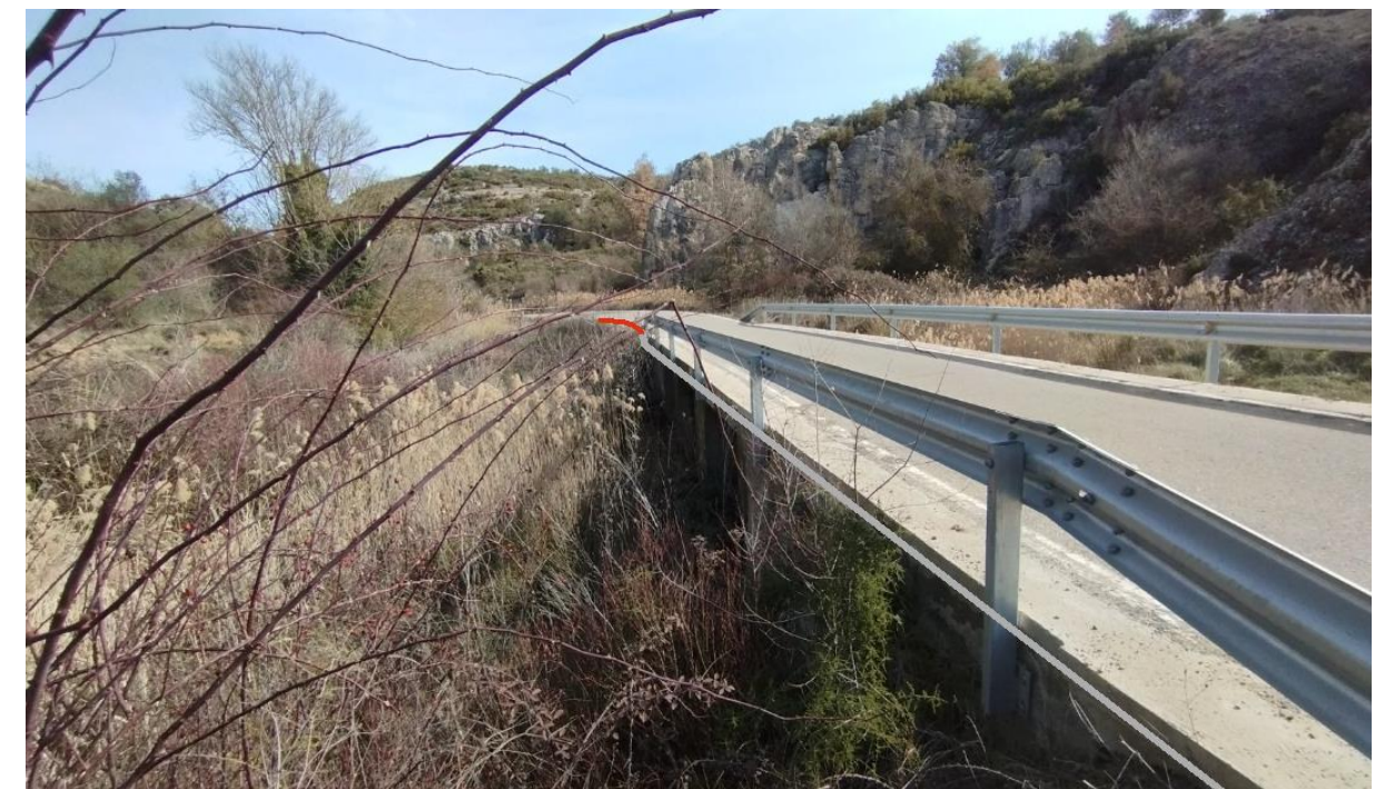
Fig 6. Nou tub metàl·lic de 1 conducte de Ø90 mm (Subconductat 6 conductes de Ø20 mm) des del canvi d'infraestructura 25156CI2805 fins al canvi d'infraestructura 25156PE2806.
