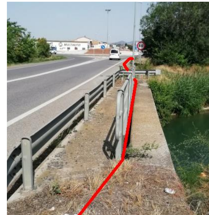
Exemple de tub metàl·lic engrapat
