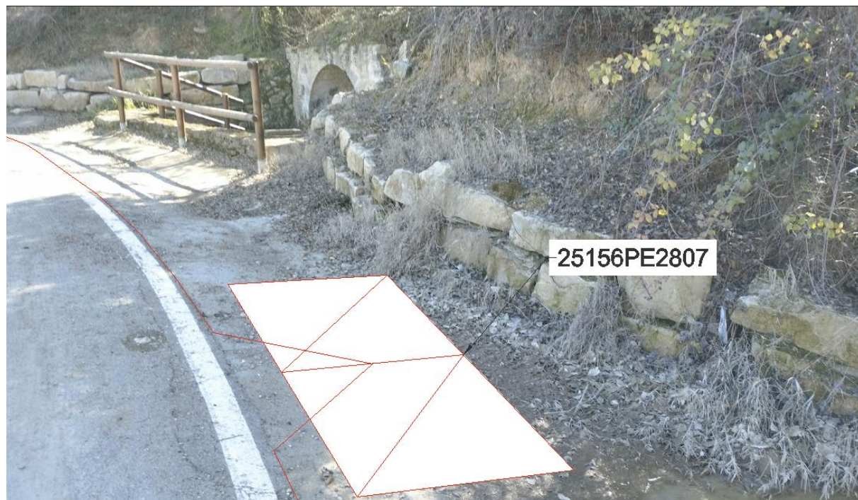
Fig 24. Nova microrasa del tipus 6c20 des del pericó en projecte (pericó tipus C2) 25156PE2807, fins al pericó en projecte (pericó tipus C2) 25156PE2808 (microrasa en asfalt i formigó).
