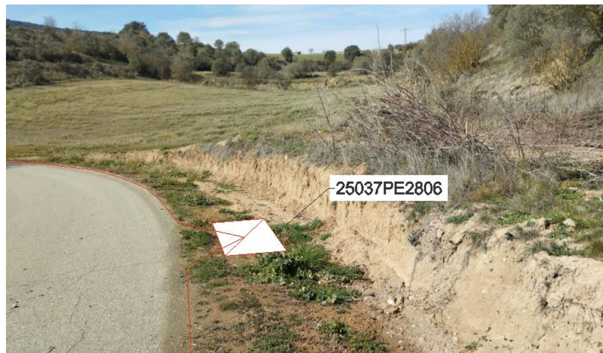
Fig 13. Nova microrasa del tipus 6c20 des del pericó en projecte (pericó tipus B2) 25037PE2806, fins al pericó en projecte (pericó tipus C2) 25037PE2807 (microrasa en asfalt i formigó).
