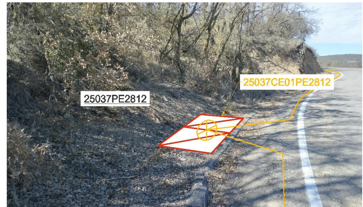
Fig 33. Instal·lació caixa d'empalmament 25037CE01PE2812.
