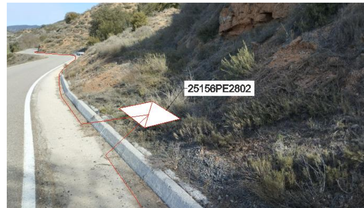
Fig 3. Nova microrasa del tipus 6c20 des del pericó en projecte (pericó tipus B2) 25156PE2802, fins al pericó en projecte (pericó tipus C2) 25907PE2803 (microrasa en formigó).
