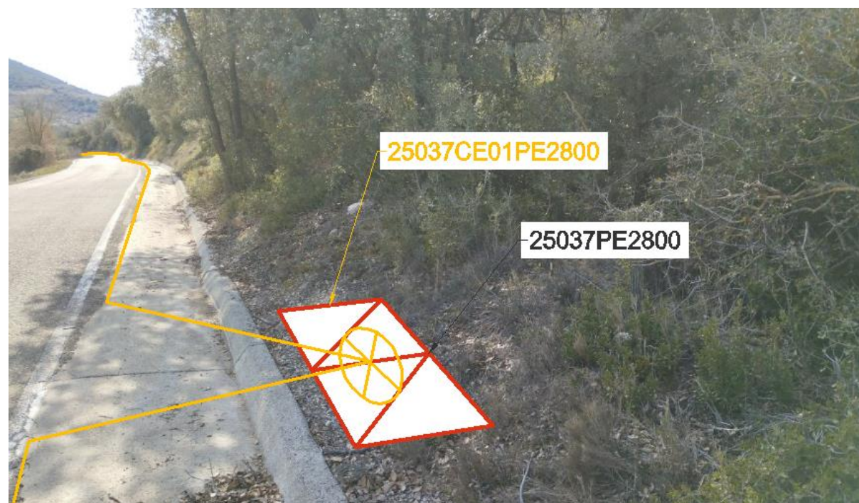
Fig 28. Instal·lació caixa d'empalmament 25037CE01PE2800.
