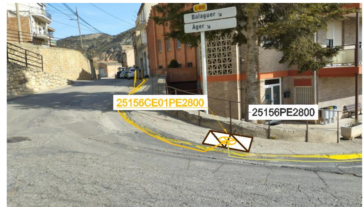
Fig 26. Instal·lació caixa d'empalmament 25156CE01PE2800.
