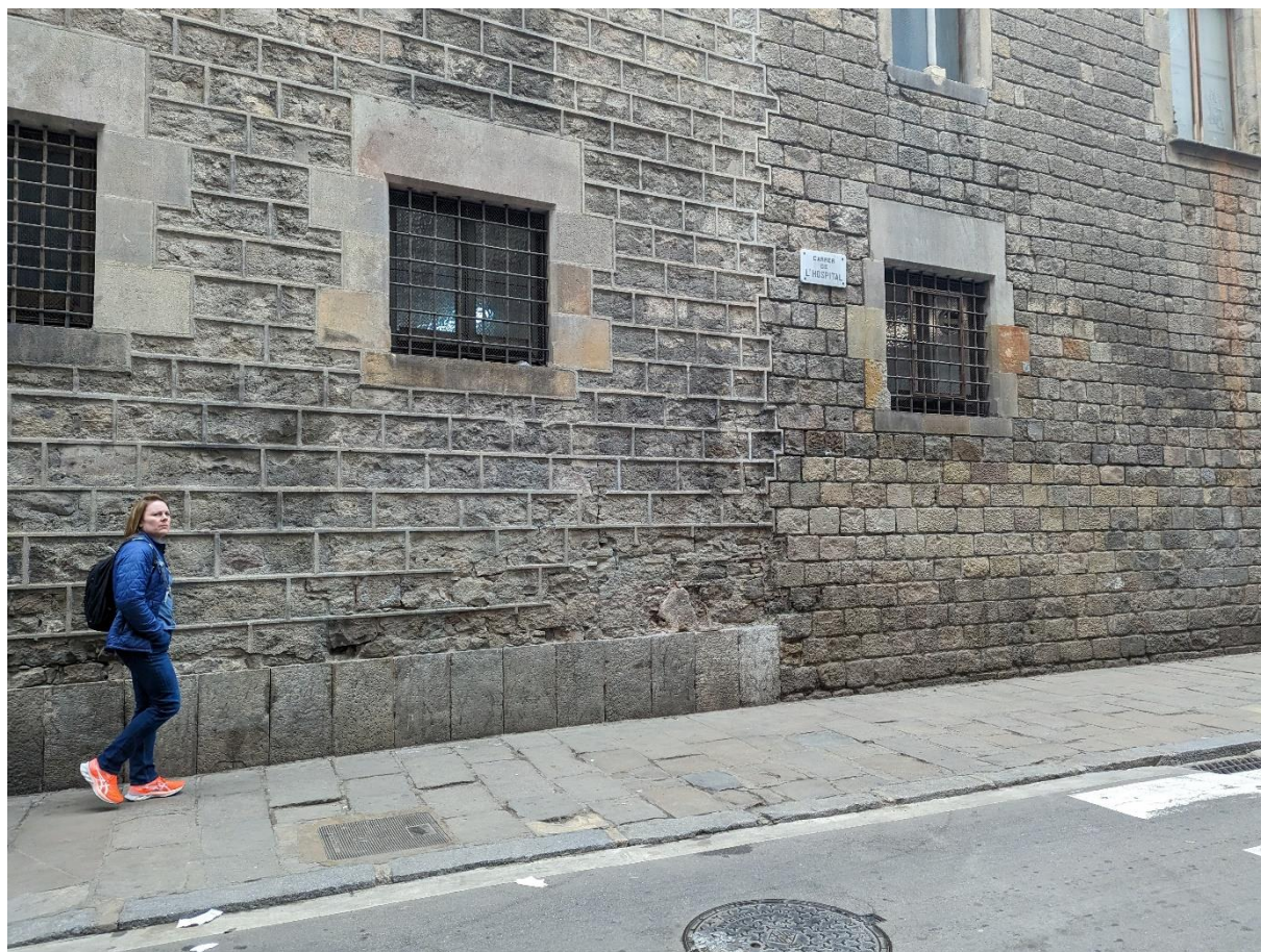
Vista de la façana de l'edifici de l'Antic Hospital de la Santa Creu des del Carrer de l'Hospital al canvi d'edificis
