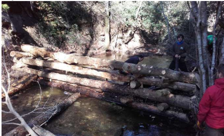
Imatge 2. Estructura de fusta d'elaboració pròpia per a la construcció d'un dic
