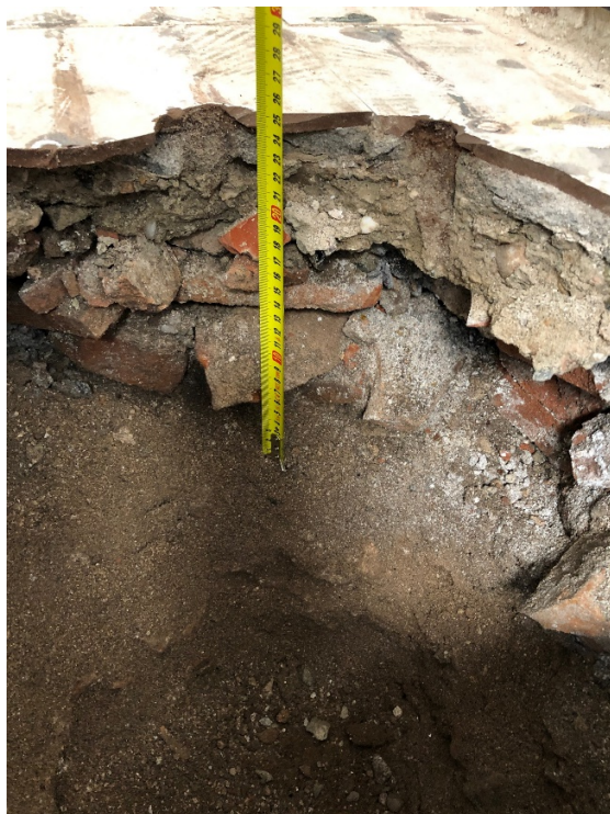
Foto 22: Cala en el graó situat entre l'espai 1 i l'espai 2 on va aparèixer la línia elèctrica de la ET a menys de 12 cm
