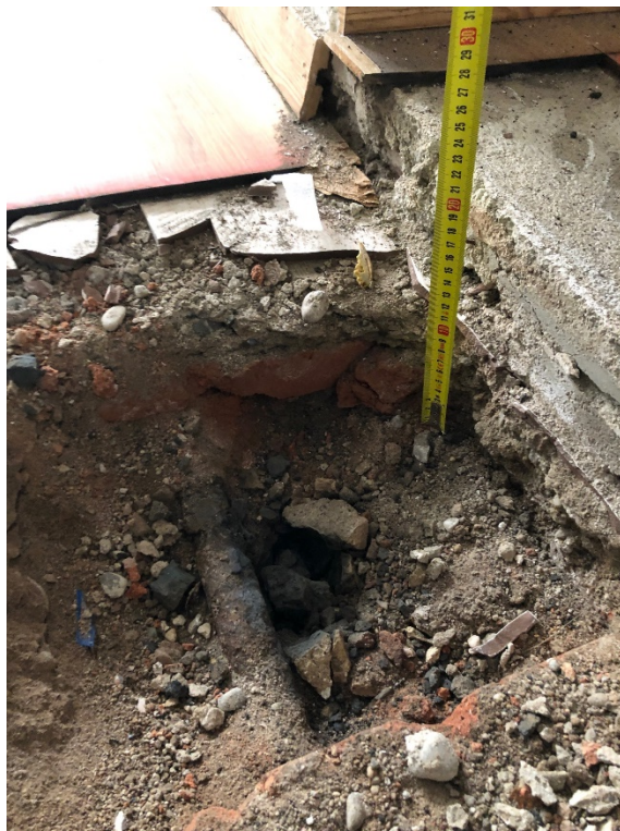
Foto 22: Cala en el graó situat entre l'espai 1 i l'espai 2 on va aparèixer la línia elèctrica de la ET a menys de 12 cm
