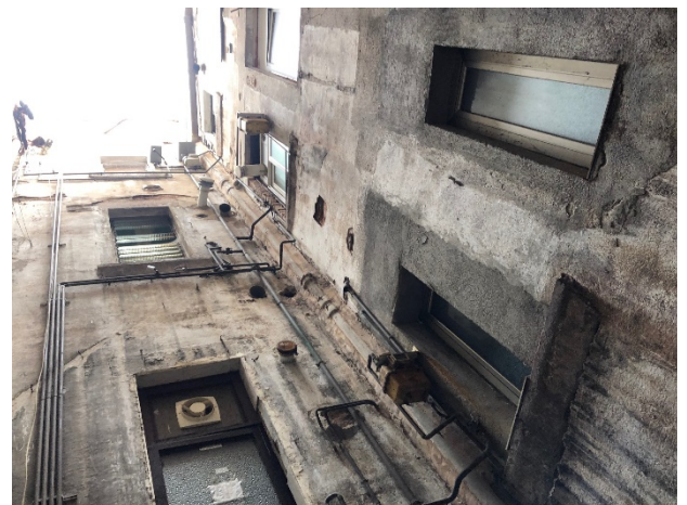
Fotos 22 i 23: Celobert interior de l'edifici.
