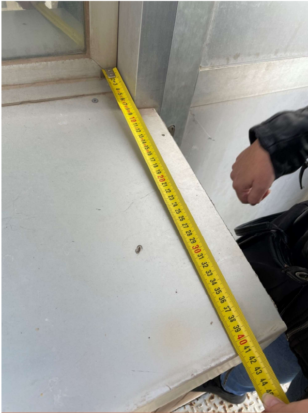
Ampit de finestra amb perfil metàl·lic
