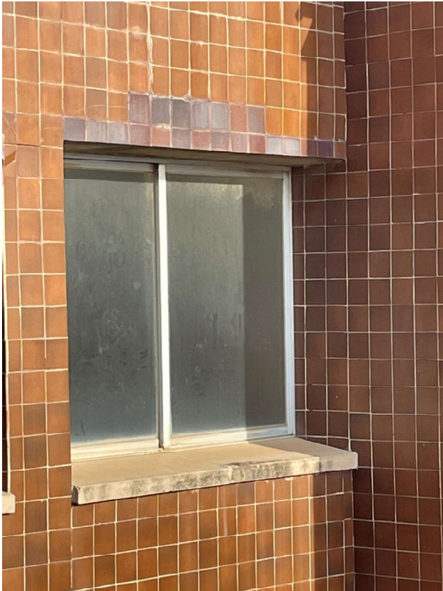
Finestra de Façana Interior Nord (ampit sense perfil metàl·lic)
