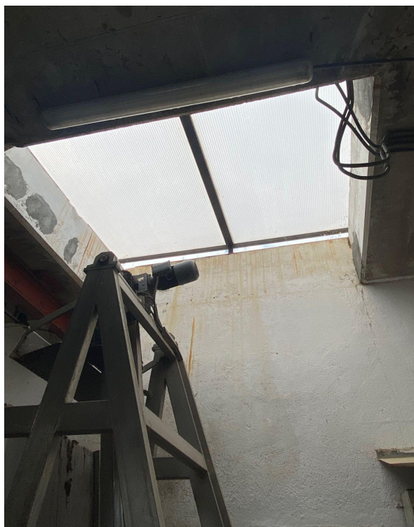
Imatge 5.- Claraboia del sostre de la sala principal del bombament per on es farà sortir a l'exterior la canonada de descàrrega del nou sistema d'extracció de gasos.
