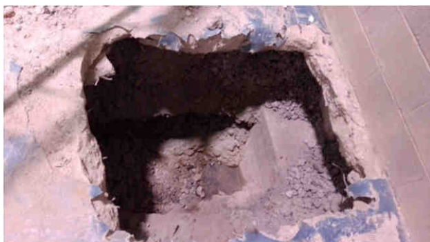
Figura 6.- Vista de la Cata 2
