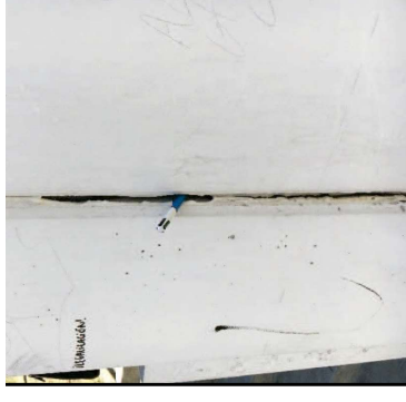
Detall de diferents esquerdes a les zones exteriors de les instal·lacions, que afecten tant a les estructures com a les canaletes.
