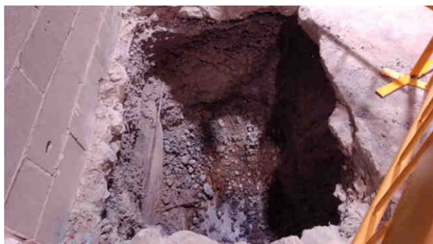
Figura 8.- Vista de la Cata 1
