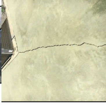
Detall de diferents esquerdes a les zones exteriors de les instal·lacions, que afecten tant a les estructures com a les canaletes.
