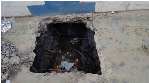
Figura 2.- Vista de la Cata 4
