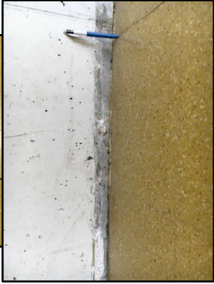
Esquerdas observades a l'interior dels passadissos i als envans, afectant les finestres, i detall de l'aixecament del paviment.
