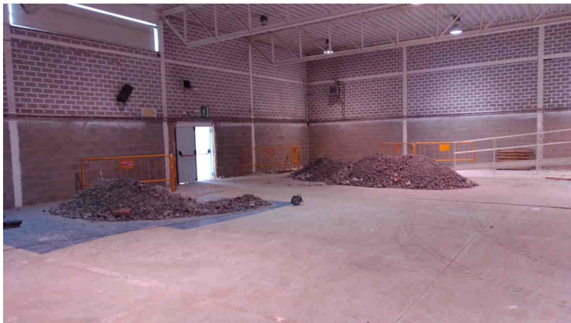
Figura 1.- Vista general de la zona de les cates 1,2 i 3
