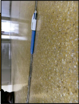
Esquerdas observades a l'interior dels passadissos i als envans, afectant les finestres, i detall de l'aixecament del paviment.
