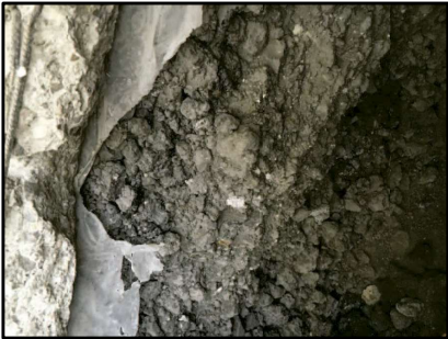
A l'esquerra, detall de l'aspecte de les escòries, i a la dreta l'excavació de la cala C-9, a cota de planta baixa, amb un gruix d'escòries de més de 2 metres.
