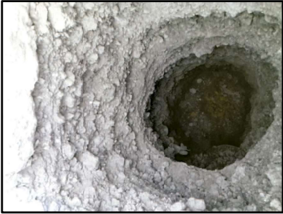
A l'esquerra, detall de l'aspecte de les escòries, i a la dreta l'excavació de la cala C-9, a cota de planta baixa, amb un gruix d'escòries de més de 2 metres.
