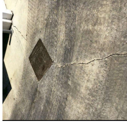
A dalt, detall del desplaçament d'una junta de dilatació a una zona de voladís. A baix, diferents esquerdes a les zones exteriors de les instal·lacions, que afecten el paviment i les arquetes.
