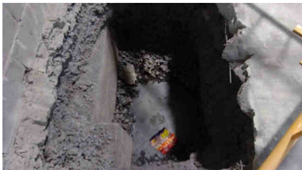
Figura 4.- Vista de la Cata 3
