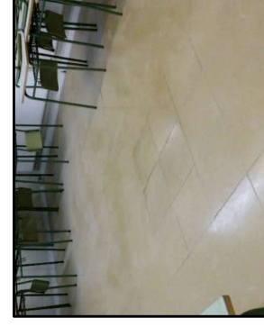
Exemple de la reposició del paviment de les cales, tant exteriors com interiors.
