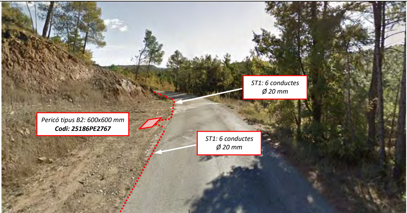
Imatge 19: Pericó tipus B2 amb codi 25186PE2767 a lateral carretera d'accés a Presa de Sant Ponç. Canalització ST1 per voral.
