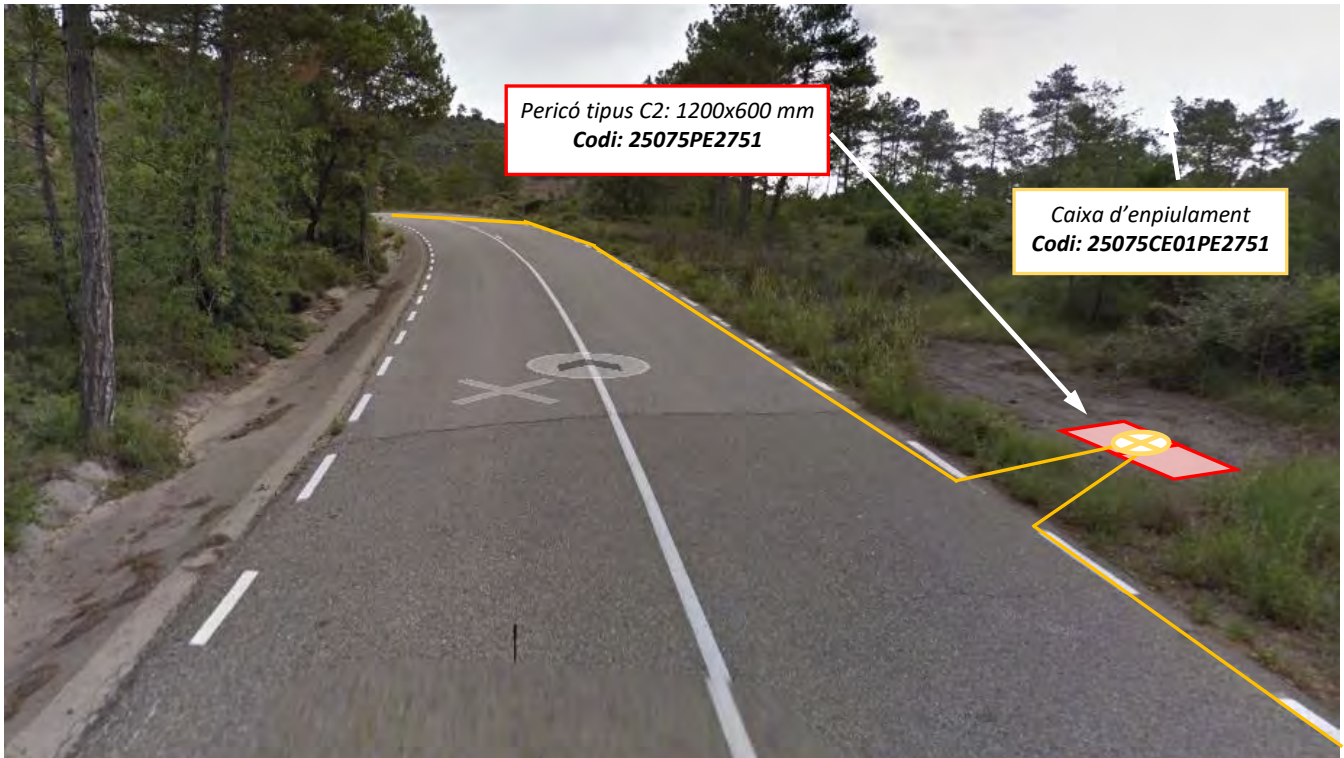
Imatge 3: Nova estesa de cablejat 144FO tipus 7 mixta des de la valona 25186VL01PE2758 fins la nova caixa d'empulament 25075CE01PE2751.
