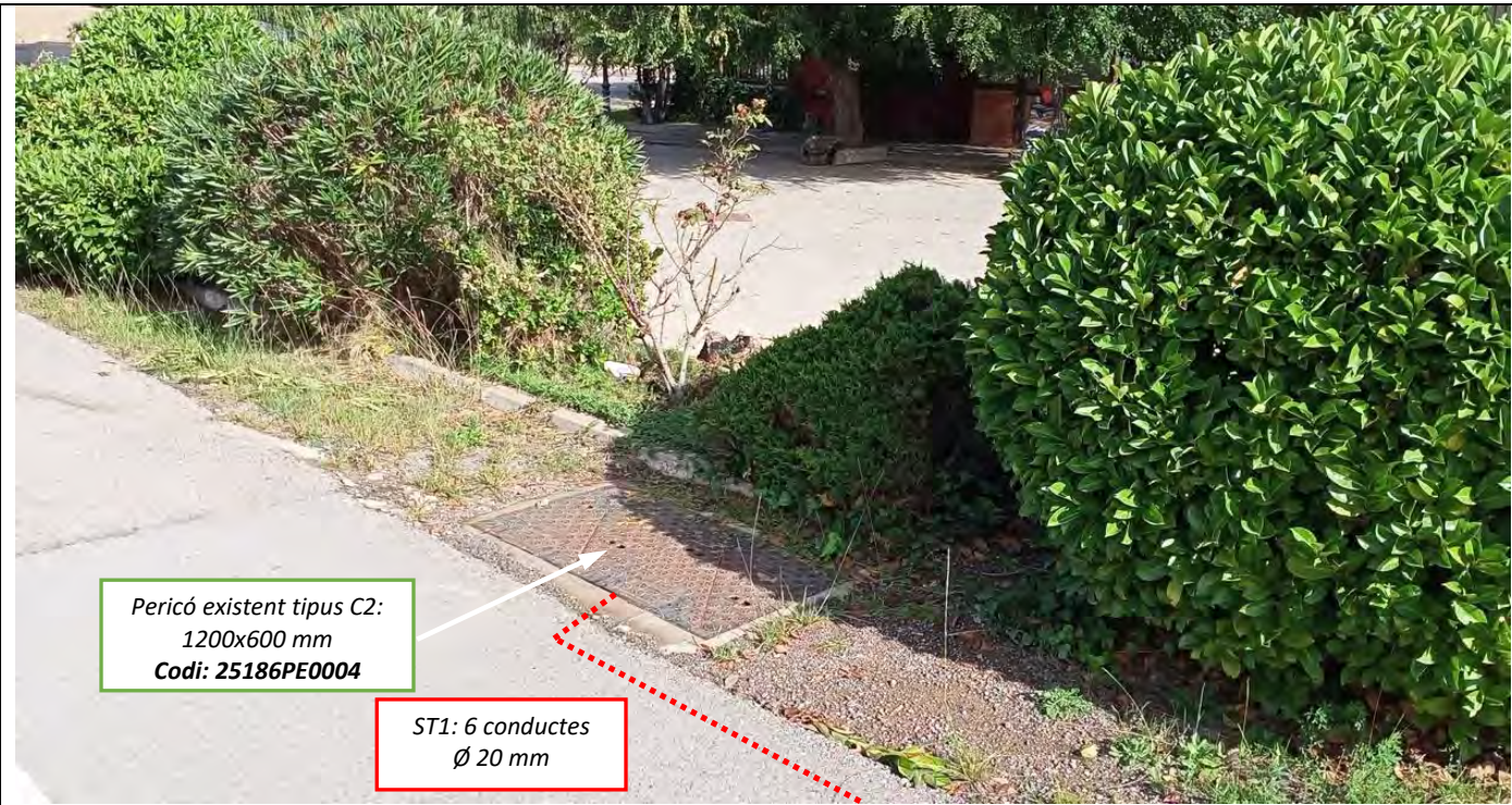
Imatge 17: La nova canalització continua des de pericó existent amb codi 25186PE0004. D'aquest surt canalització tipus ST1 voral.
