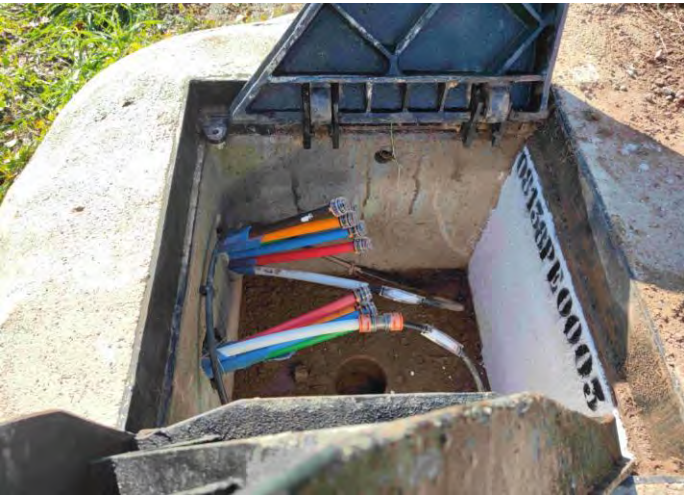
Exemple de tall dels microductes i taps d’obturgació.
