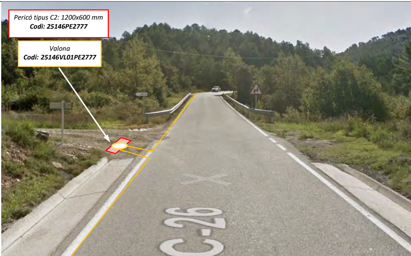
Imatge 15: Nova estesa de cablejat 144FO tipus 7 mixta des de la nova caixa d'empulament 08132CE01PE2772 fins la nova valona 25146VL01PE2777.
