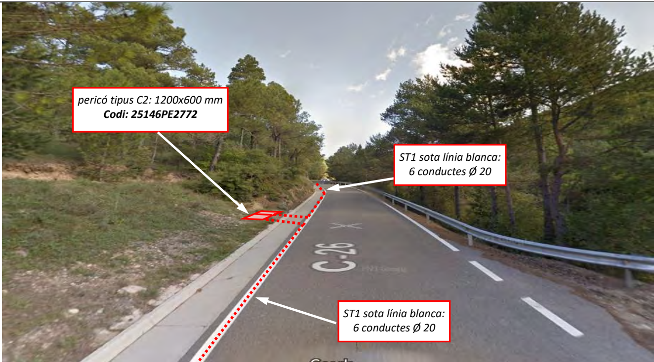
Imatge 52: Pericó tipus C2 (25146PE2772) en marge de la C-26 PK124+205. Arribem amb ST1 sota línia blanca i continuem amb el mateix tipus de canalització.
