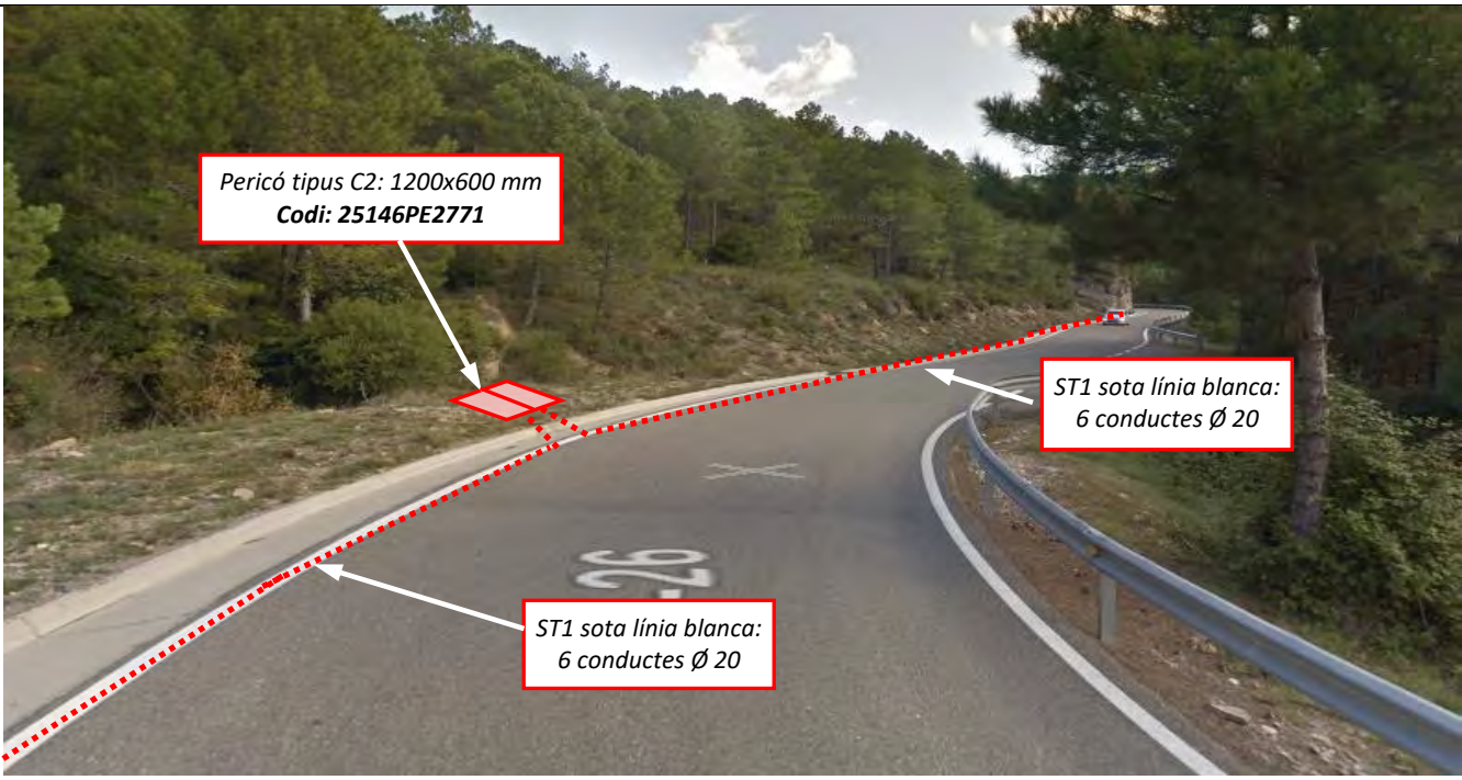
Imatge 51: Pericó C2 (25146PE2771) al PK 123+050 de la C-26. S'entra i es surt amb canalització ST1 sota línia blanca.
