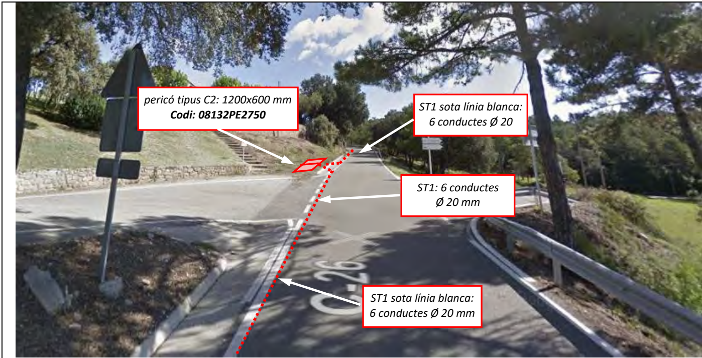
Imatge 45: Davant de l'accés de la Granja Els Plans es situarà pericó tipus C2(08132PE2750). A aquesta s'arribarà amb canalització ST1 propiciada pel creuament del vial d'accés i sortirà canalització ST1 sota línia blanca.
