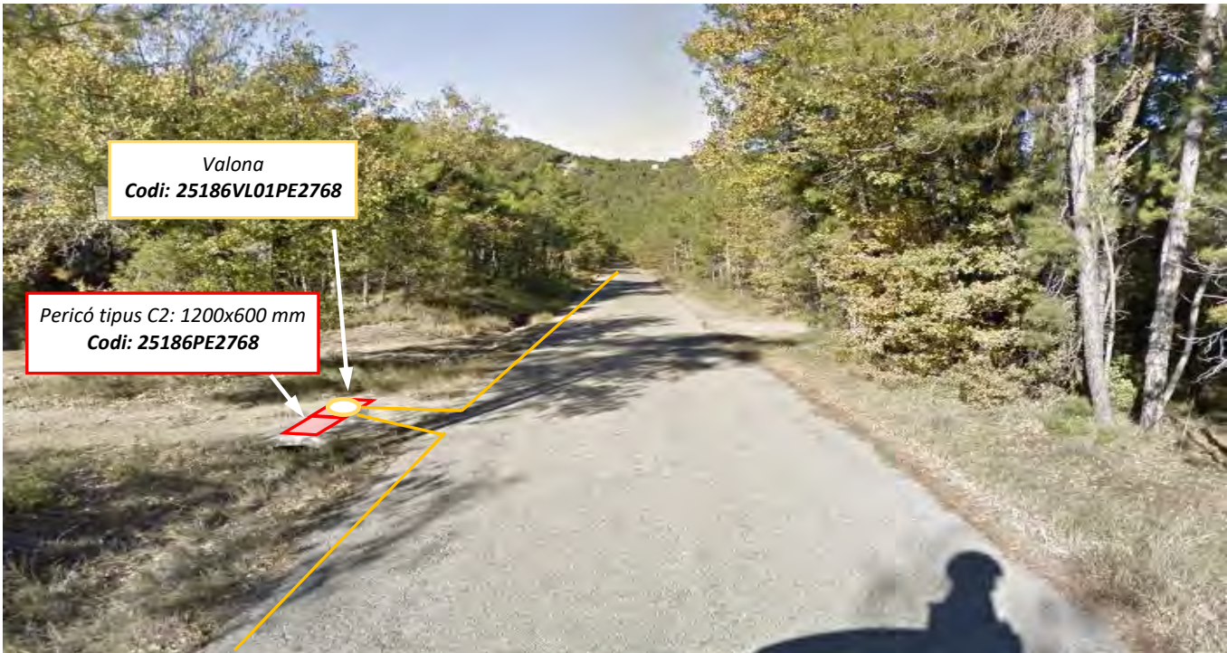
Imatge 5: Nova estesa de cablejat 144FO tipus 7 mixta des de la caixa d'empulament existent 25186CE01PE0004 fins a la nova valona 25186VL01PE2768
