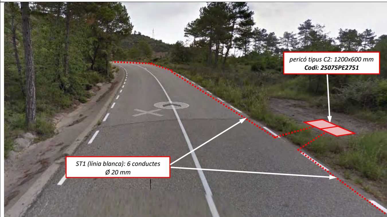
Imatge 10: Pericó C2 (codi: 25075PE2751) a 583 metres de l'anterior B2. La canalització continua sent ST1 sota línia blanca.
