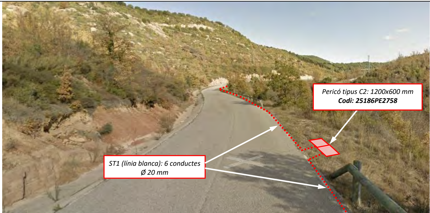
Imatge 7: Arribada a pericó tipus C2 amb codi: 25186PE2758 des de l'anterior pericó B2 mitjançant canalització tipus ST1 sota línia blanca. Continuem amb mateixa secció fins a incorporació del camí de Cal Sait.
