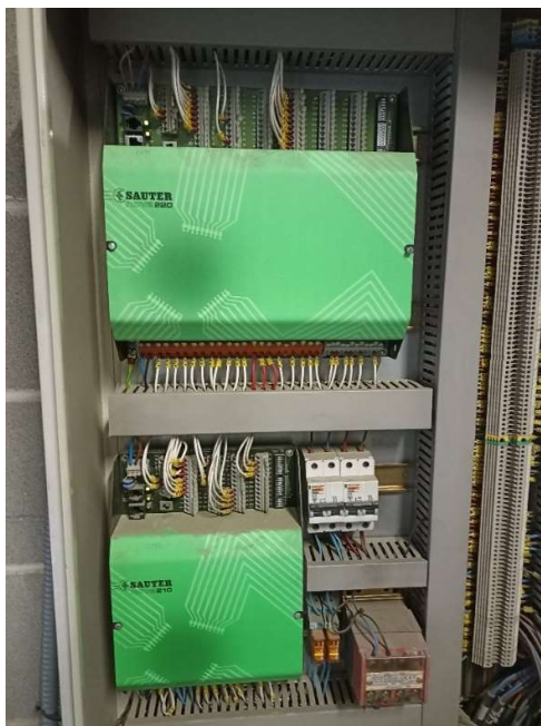
Imatge 8 Interior quadre tipus Palau 3
