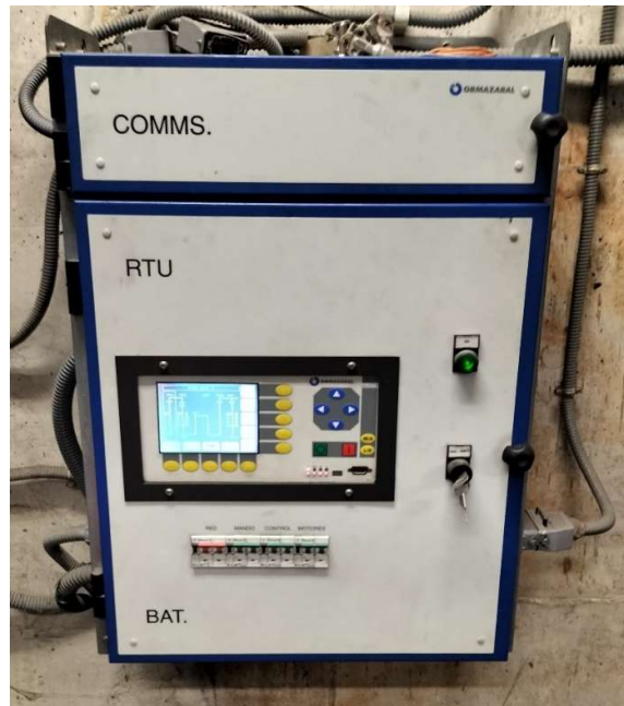
Imatge 10 Quadre PLC EKOR Palau 6 (ídem palau 2)
