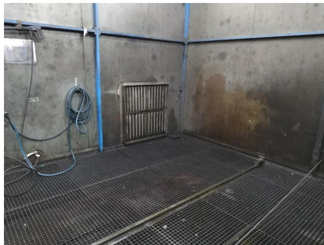
Figura 2 Interior de la cabina de rentat
