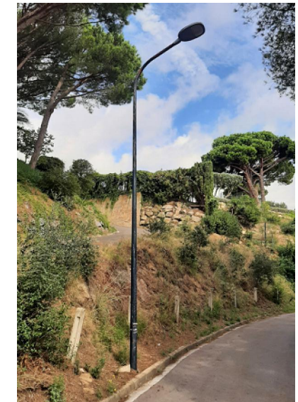
Substitució de bàcul existent per columna troncocònica de 8,00m d'alçada i trasllat de luminària existent. (tram fanals 16 al 22)
