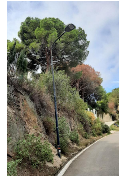
Substitució de bàcul existent per columna troncocònica de 8,00m d'alçada i trasllat de luminària existent. (tram fanals 16 al 22)
