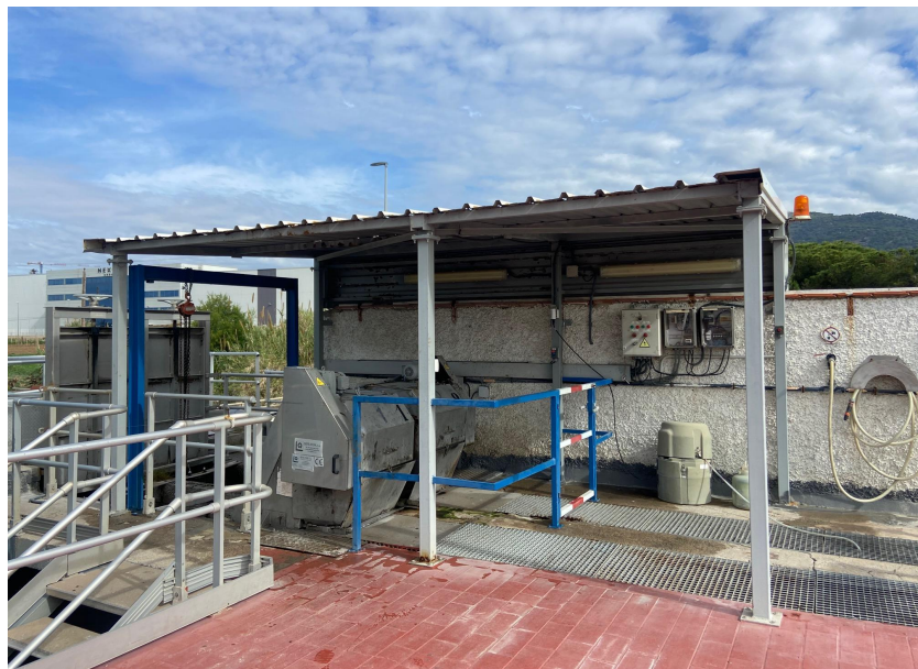
Imatge 2.- Marquesina existent que protegeix els tamisos i que s'haurà de desmuntar, i posteriorment tornar a muntar, per la instal·lació del tamís nou.
