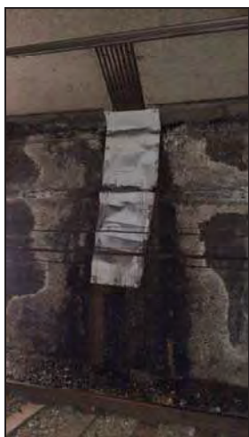
Foto 5: Filtració pantalla-volta PK 105+750 v1.
