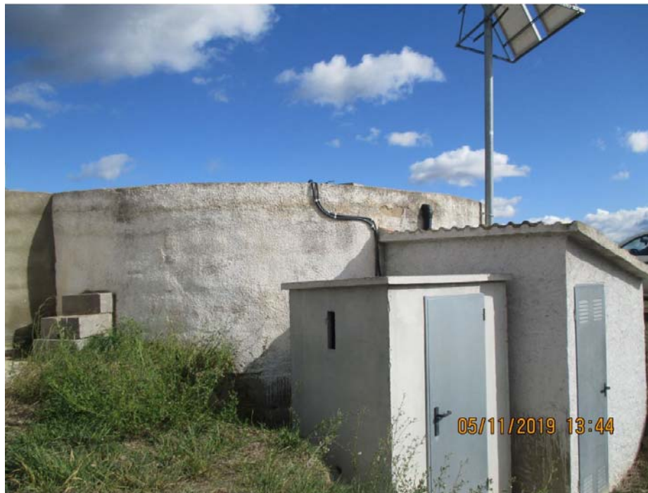
2. Dipòsit de Bonany i caseta d'instal·lacions
