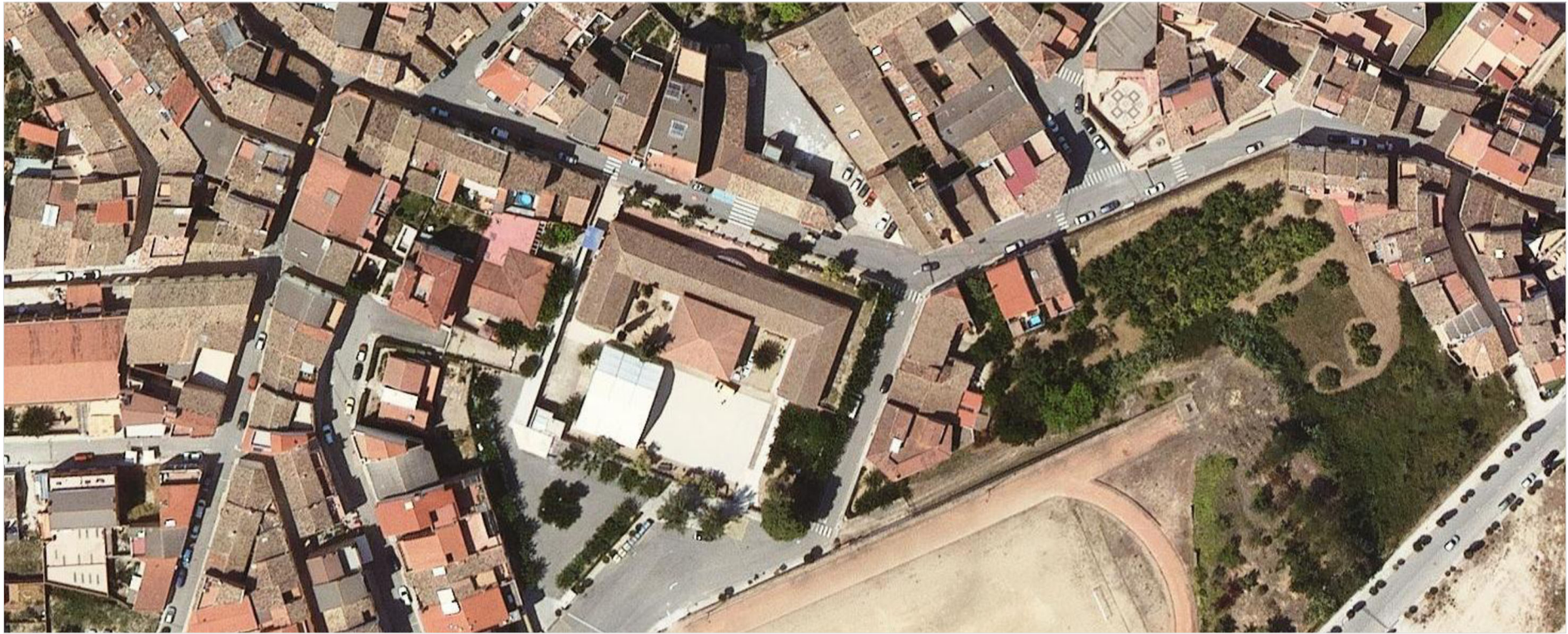
Vista aèria de l'emplaçament de la instal·lació
