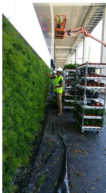
Sistemas de elevación 2. Instalación de sistemas de paneles con vegetación directamente sobre rastrillos.
