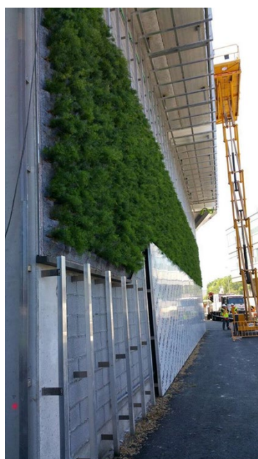
Sistemas de elevación 2. Instalación de sistemas de paneles con vegetación directamente sobre rastrillos.
