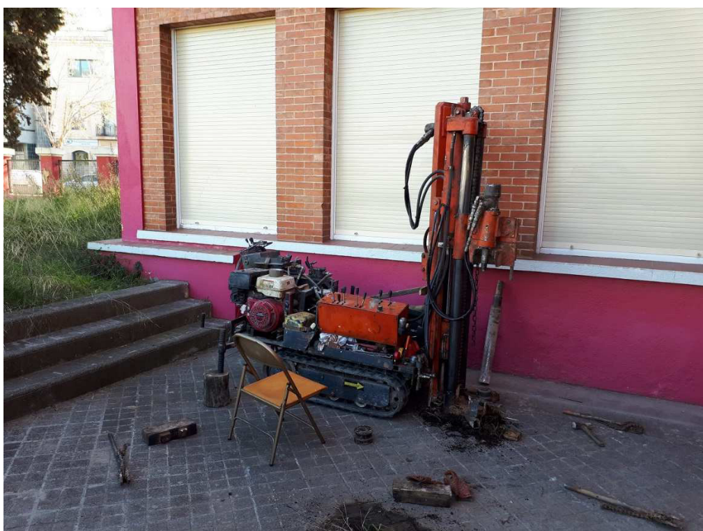
Figura 1. Execució del sondeig S-3R.
