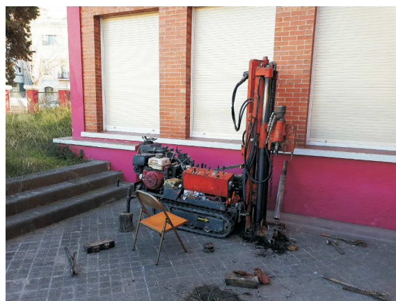
Fotografia 4. Execució del sondeig S-3R.
