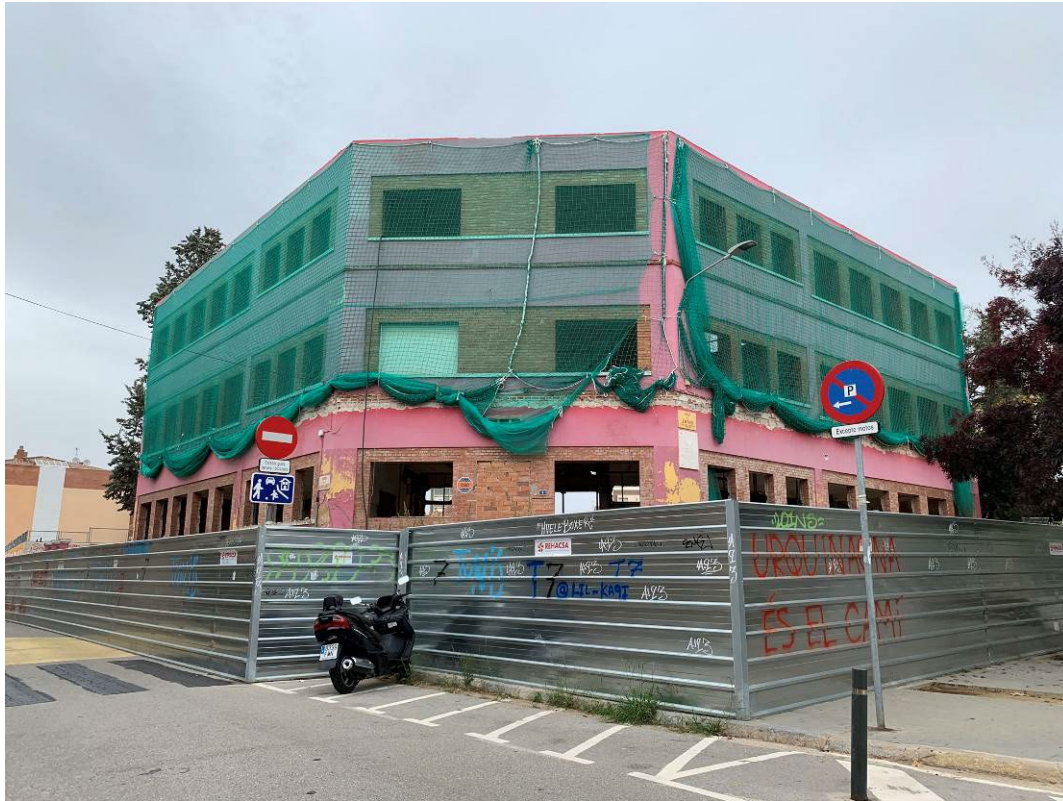
Foto 13: Façana plaça Jean piaget, estat actual. Autor: ROA Arquitectura
