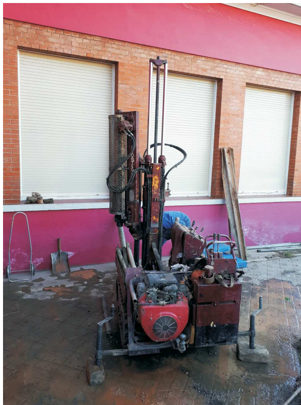
Fotografia 4. Execució del sondeig S-2R.
