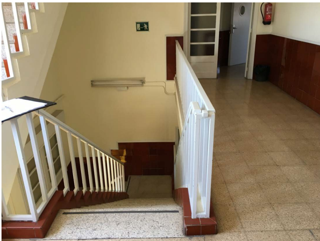
Foto 16: Interior. Zona escala i vestíbuls. Autor: ROA Arquitectura
