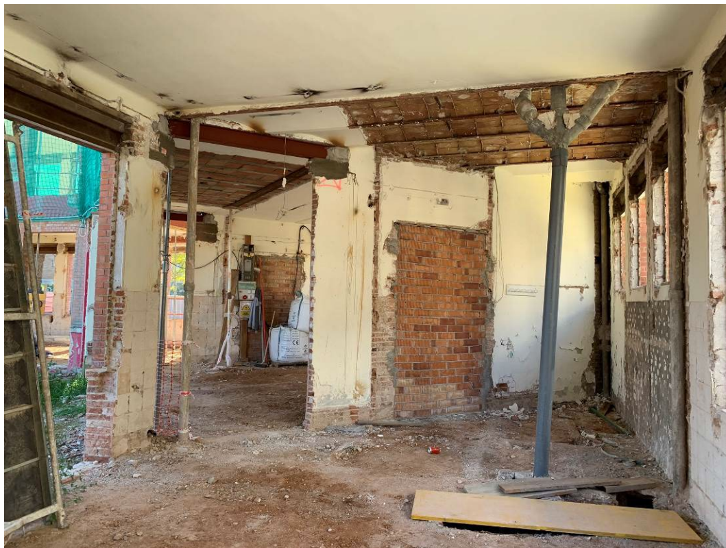
Foto 17: Interior enderrocant. Zona ala oest i ala central. Autor: ROA Arquitectura
