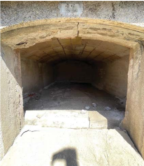
Esquerda en la llinda en una planta coberta que sí traspassa a la volta.
