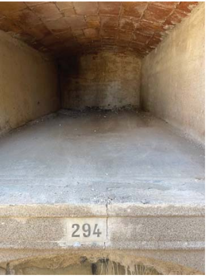
Esquerda en la llinda en una planta mitja que no traspassa a la volta.
