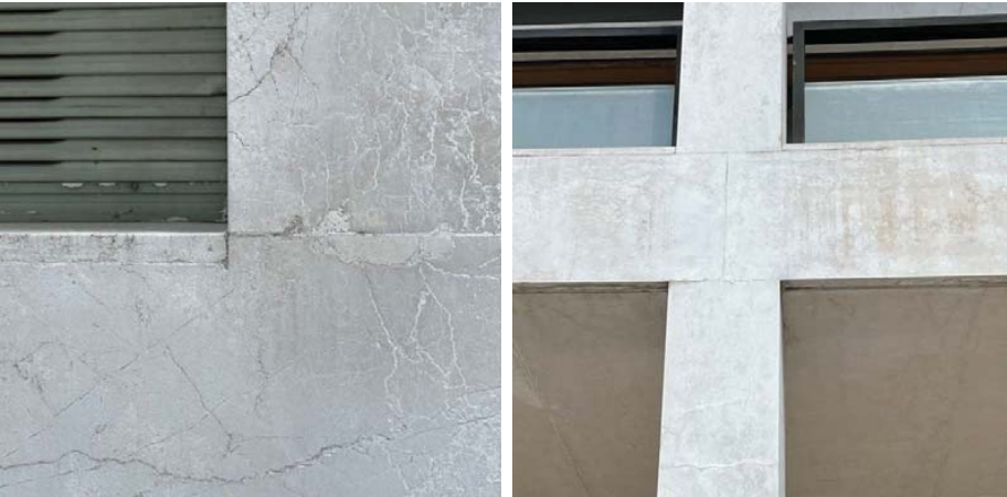
Detall de l'entrega dels aplacats de pedra. Casa a la Piazza del Popolo a Como. Terragni
