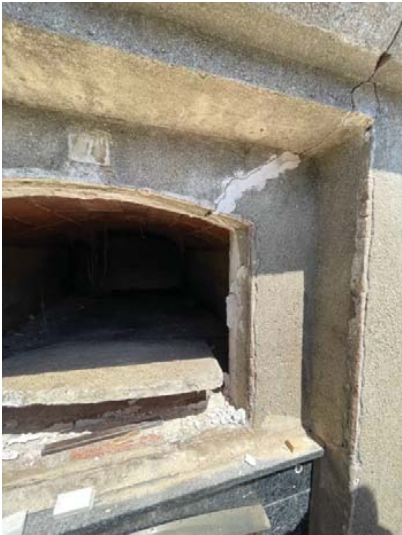
Foto i detall de les esquerdes verticals trencant en les llindes i la coronació de coberta.
