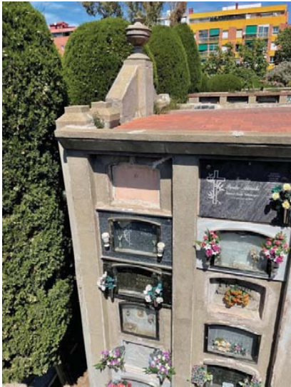
Foto i detall de les esquerdes verticals trencant en les llindes i la coronació de coberta.
