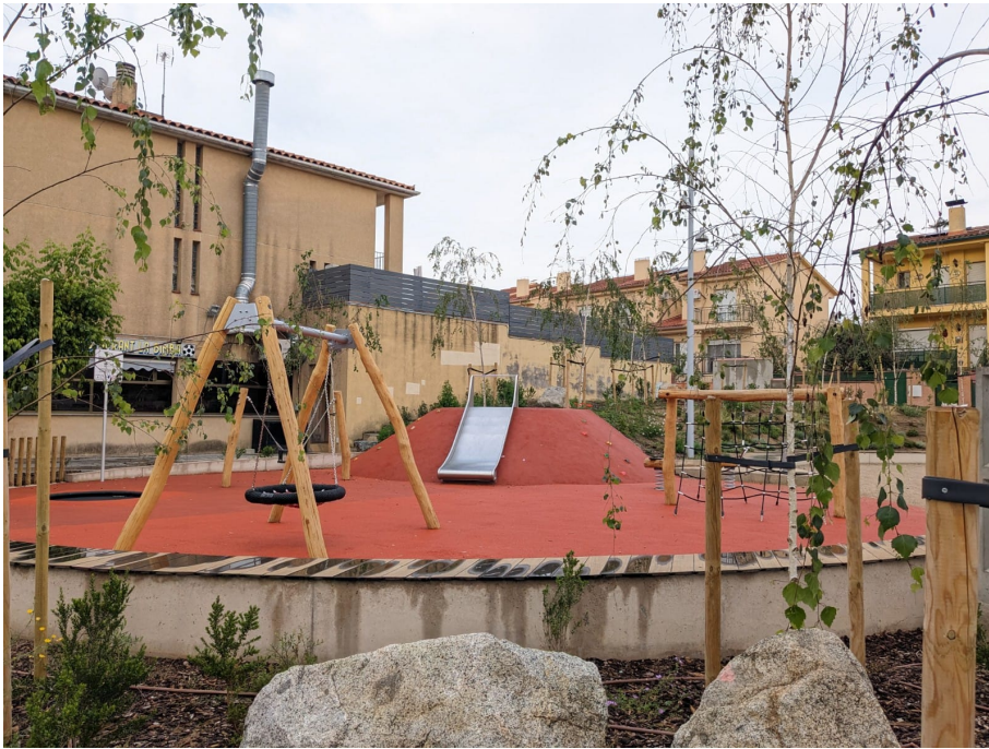
Vista 2. Zona jocs
