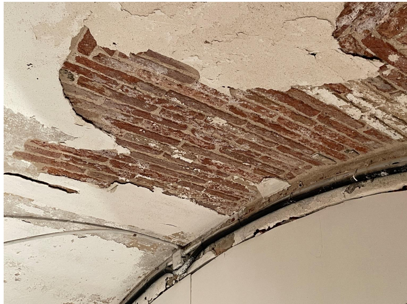
Imatges de les voltes de maó a sardinell.
