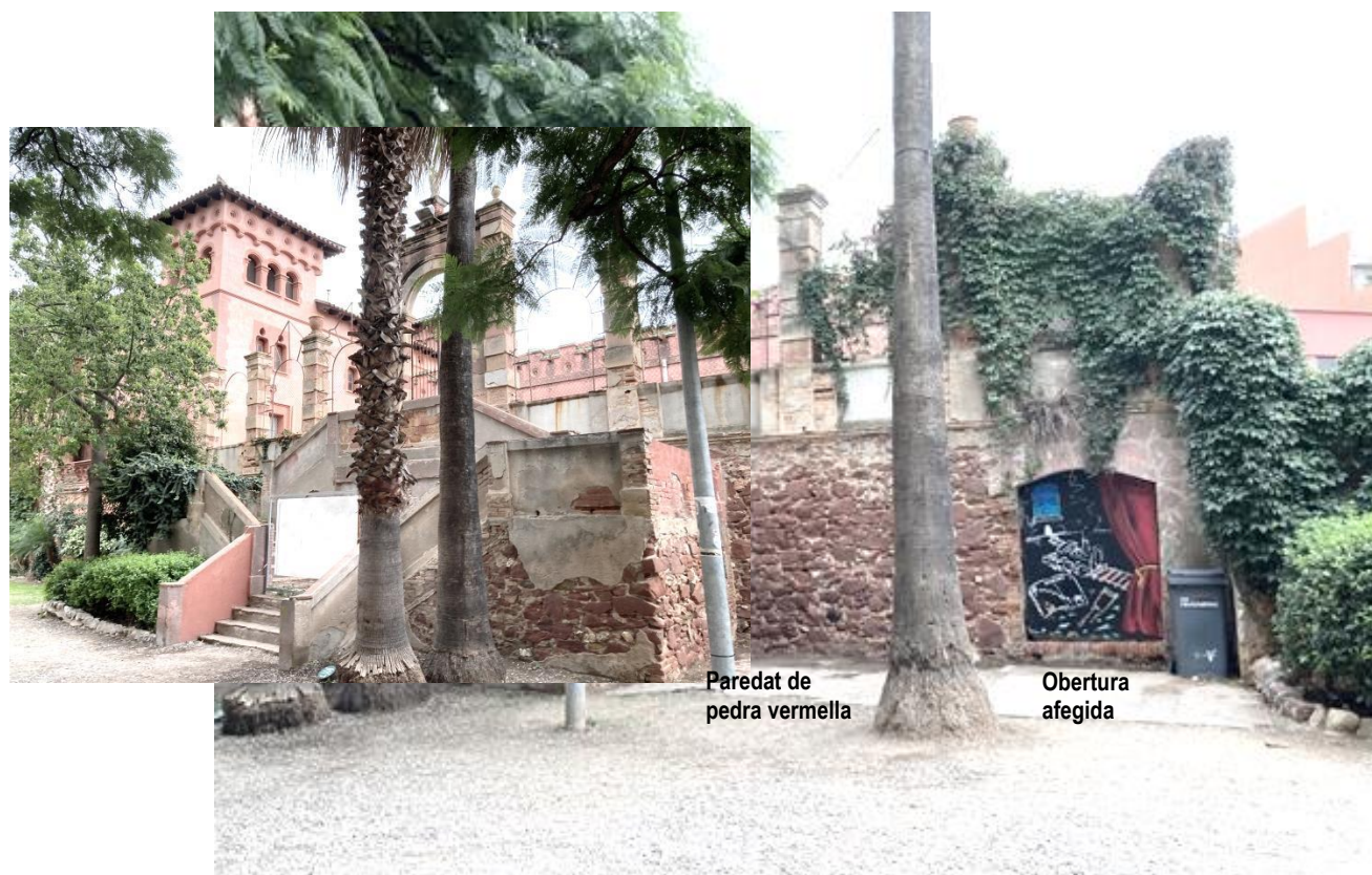
Imatges de la façana nord dels cossos afegits a la Cambra Agrària. S'observa el paredat i les obertures afegides. També la voluntat de relació manifesta amb el jardí.
