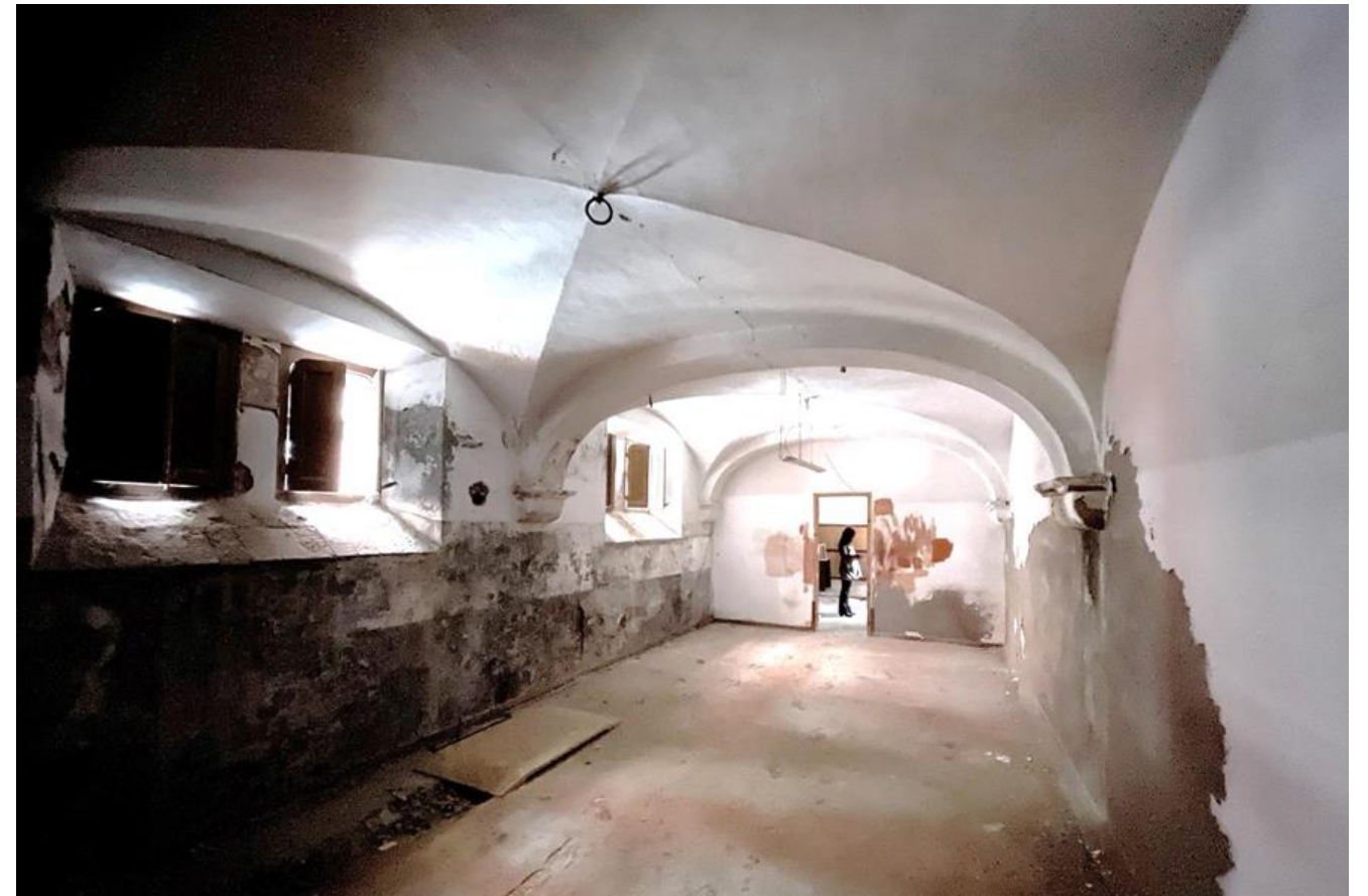
Les imatges mostren l'estat dels interiors de la planta baixa de la Cambra Agrària, on predominen les humitats procedents del terreny.
