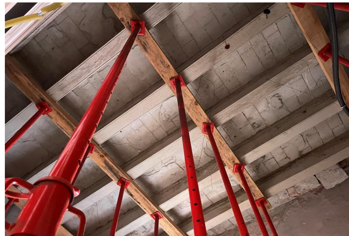
Imatge del sostre de la planta primera de la Cambra Agrària. Aquest sostre es troba tot apuntalat amb bigues podrides i en mal estat.
