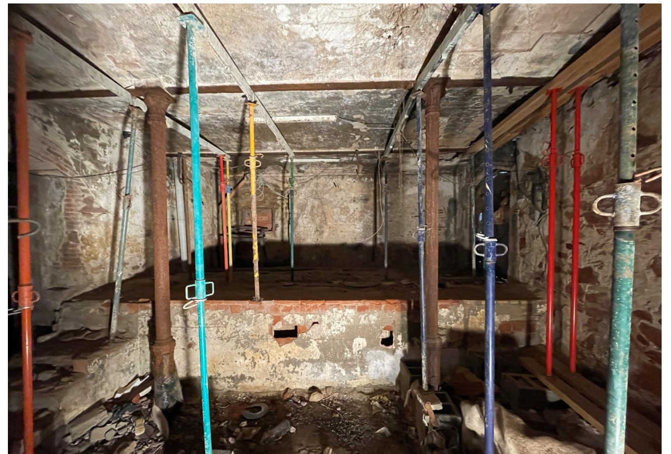
Imatges del pilars de fosa del cos nord de 1892 i de les voltes de rajola doblada (volta catalana) recolzada sobre biguetes metàl·liques.
