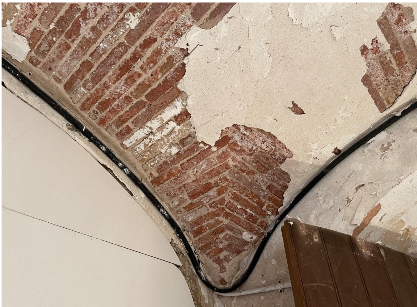
Imatges de les voltes de maó a sardinell, arrebossades i pintades.
