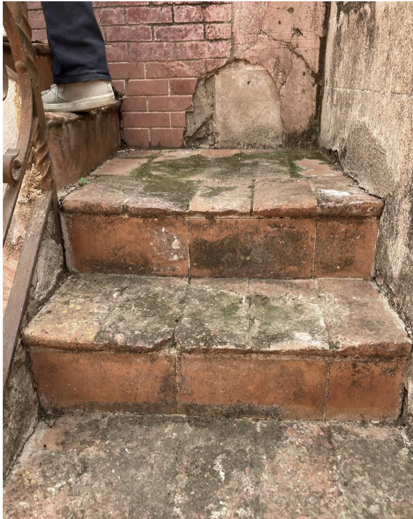
Les escales que formen part de la configuració de les façanes d'aquest àmbit, també es troben en mal estat de conservació. Existeixen pèrdues de material, presència d'agents orgànics, eflorescències, escrostaments, llacunes, degradació de la pintura,...
