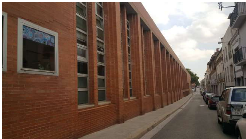
Vista façana carrer Fèlix Amat
