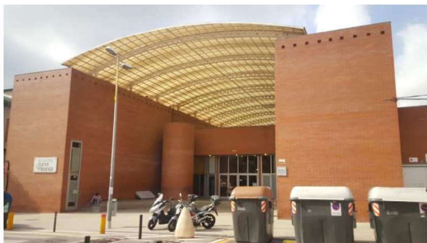
Accés principal carrer Sallarès i Pla
