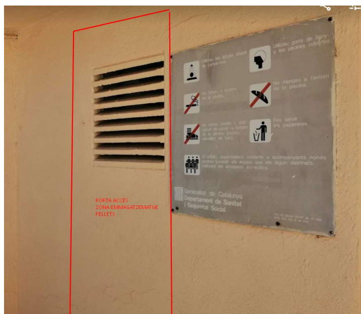
Es mostra la ubicació del tancament d'accés a la sala d'emmagatzematge de biomassa.
