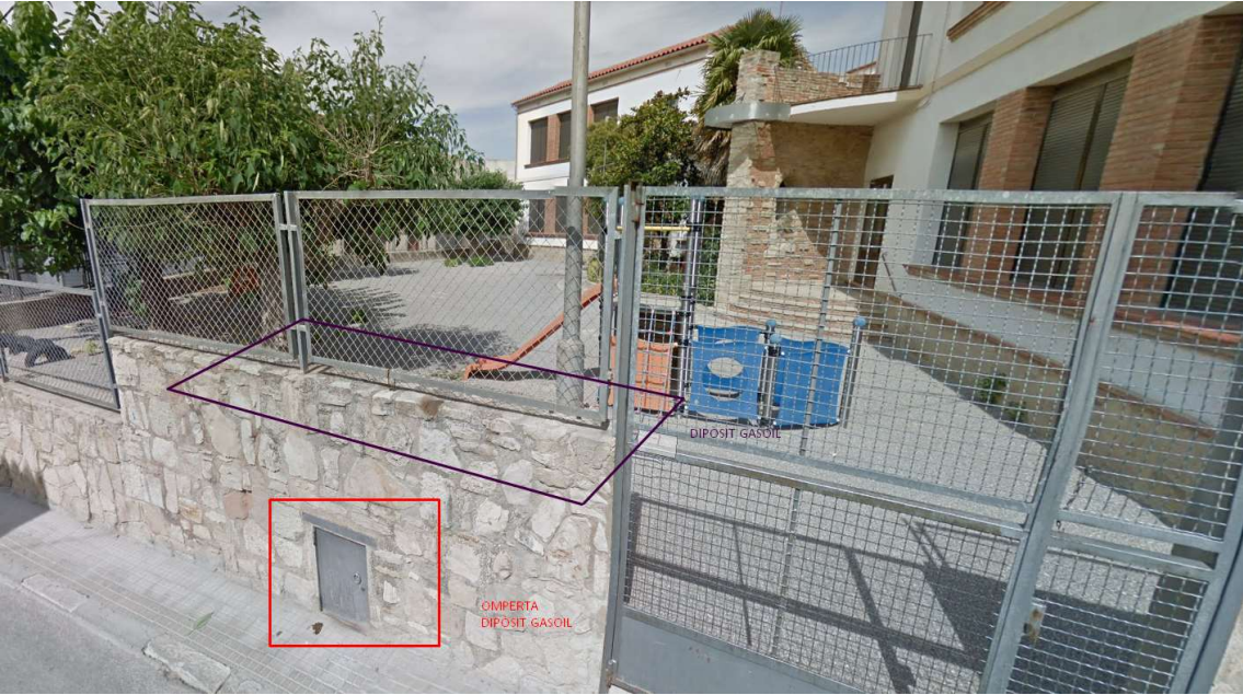
Ubicació del dipòsit de gasoil que actualment alimenta la instal·lació.
