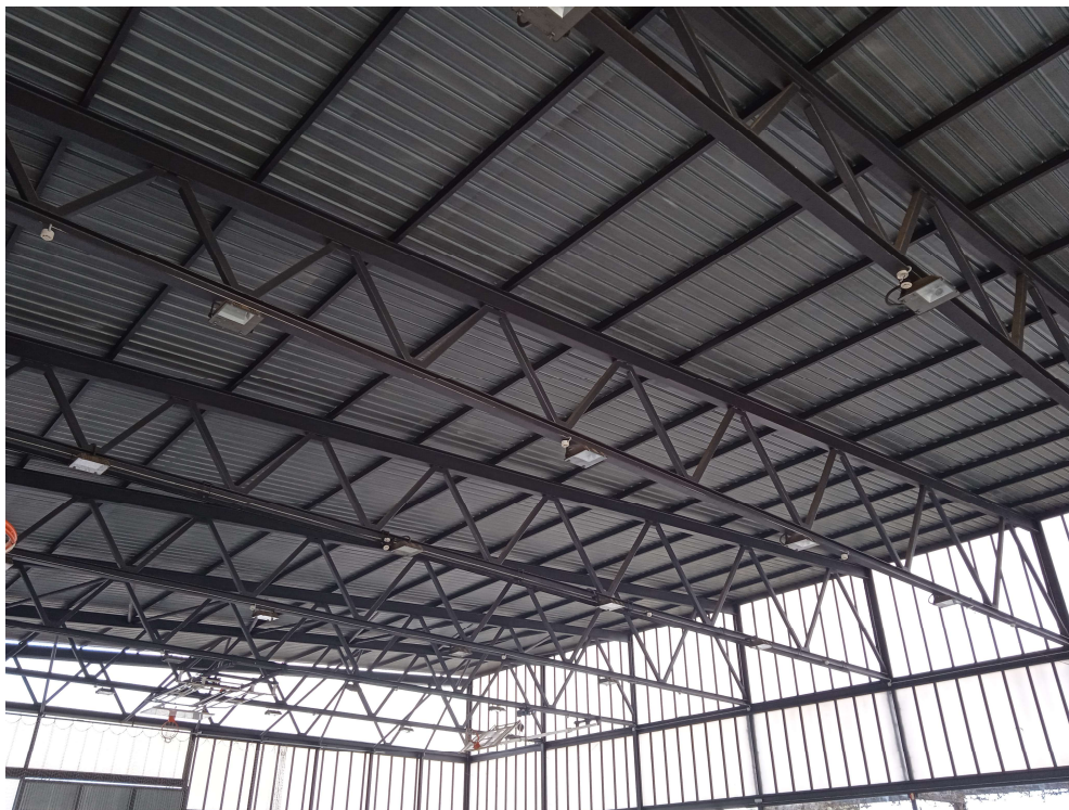
Imatges de la coberta de la nau
