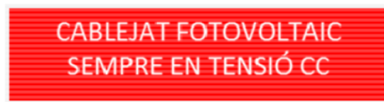
Figura 13. Senyalització cablejat CC. Font: Bombers de Barcelona.
