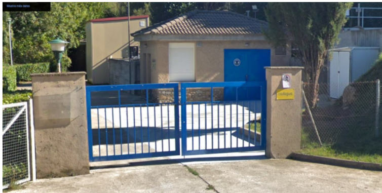
-fotografia de la porta que requereix automatització-
