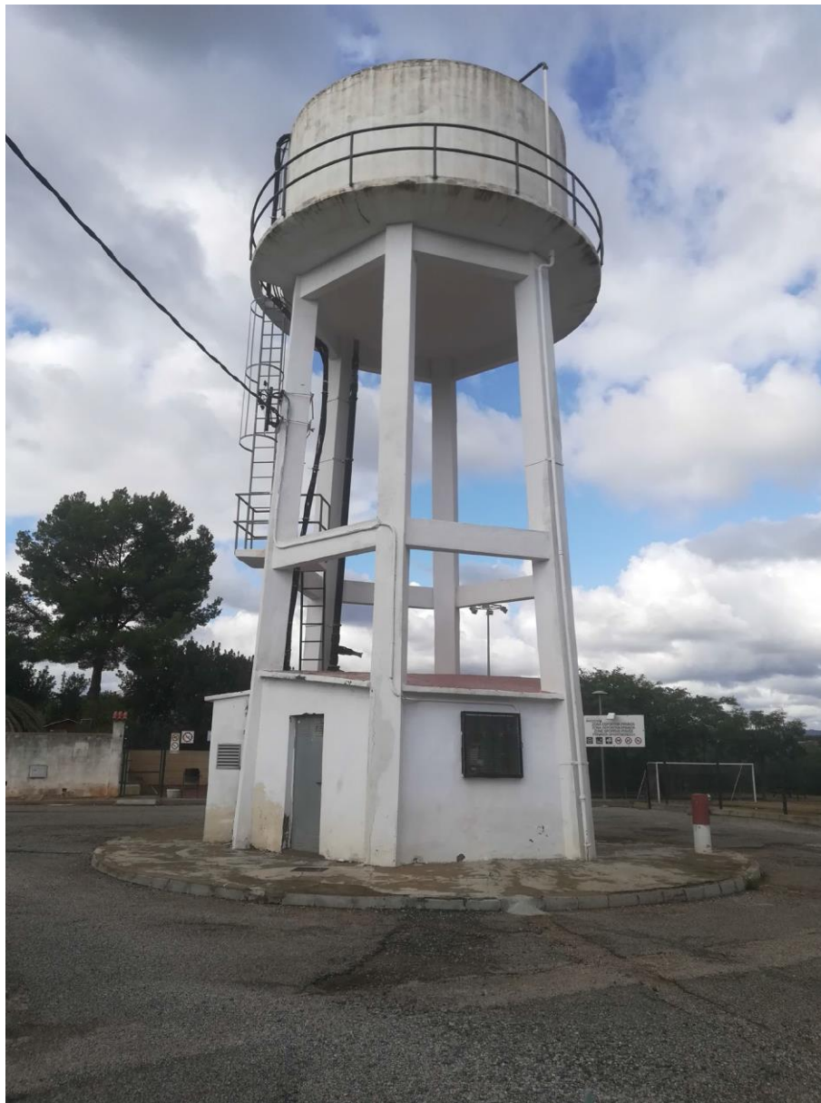
Foto 1 : Dipòsit Sant Miquel que s'haurà d'anul·lar. Zona de connexió amb la canonada existent, entre el C/ de Dalt i l'Avinguda de la Poquerola..
