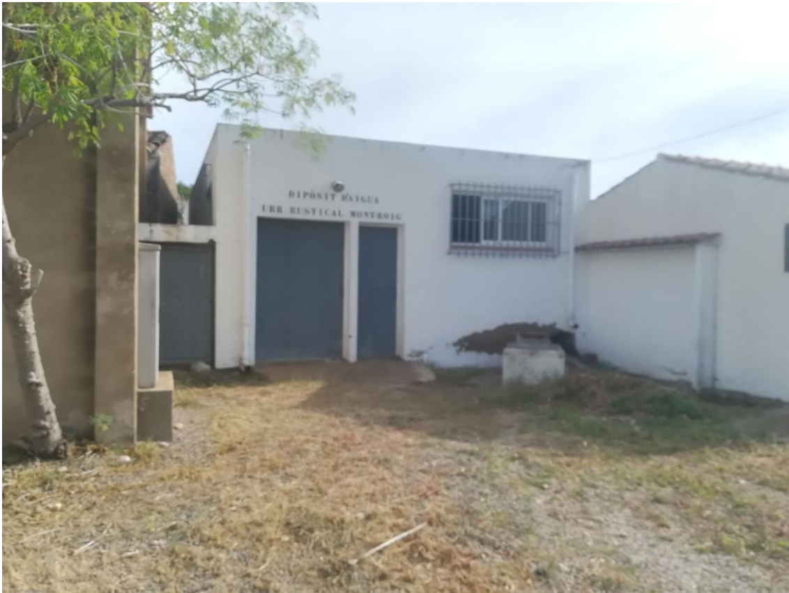
Foto 8 : Dipòsit Urb.Rustical Mont-Roig, connexions canonades projectades.
