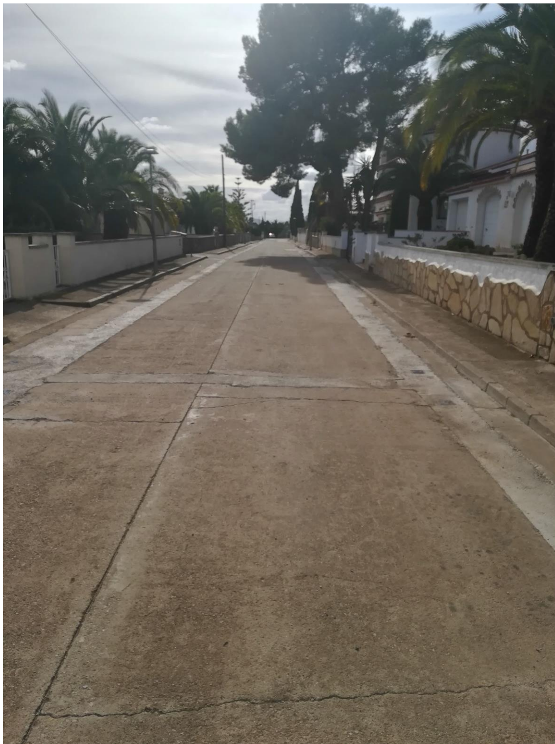
Foto 7 : Carrer de la Camamilla, traçat canonades projectades.
