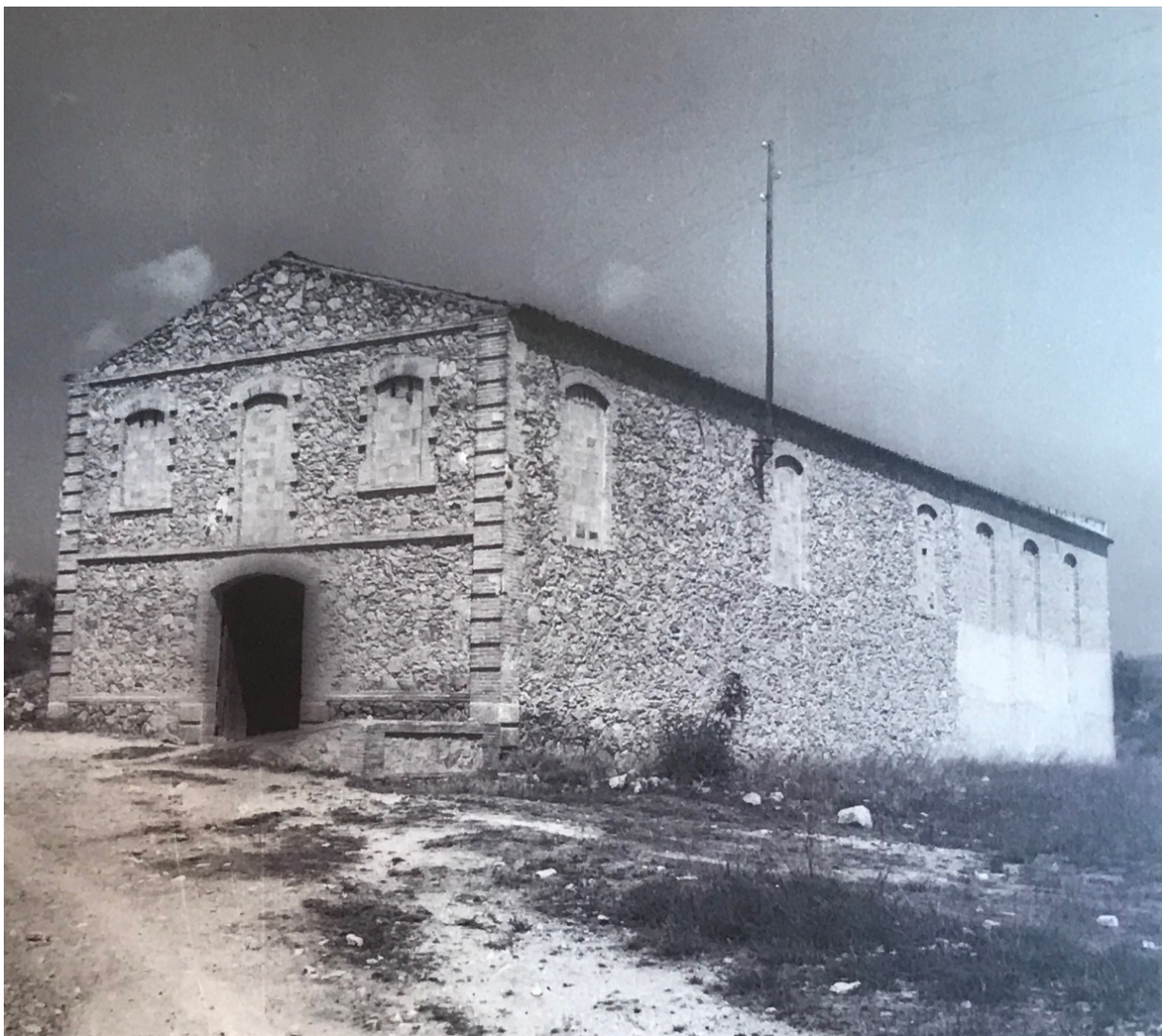
Nau històrica de l'any 1933, llavors es construïren les dues naus l'any 1961 seguint aquesta com a pauta formal.
