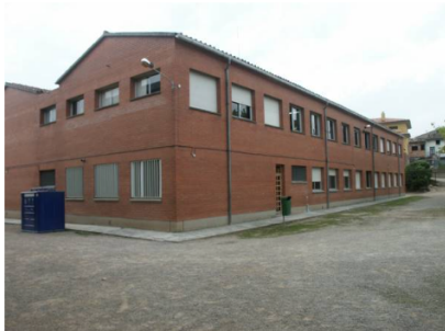
Edifici primària existent
