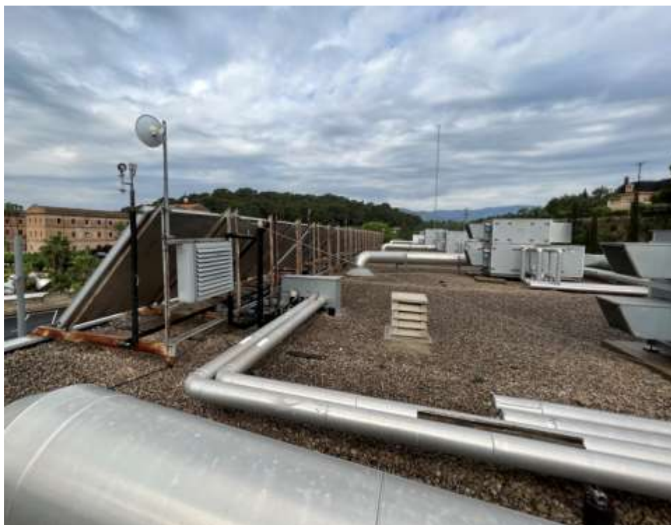
Foto.- Traçat exterior en planta coberta.
