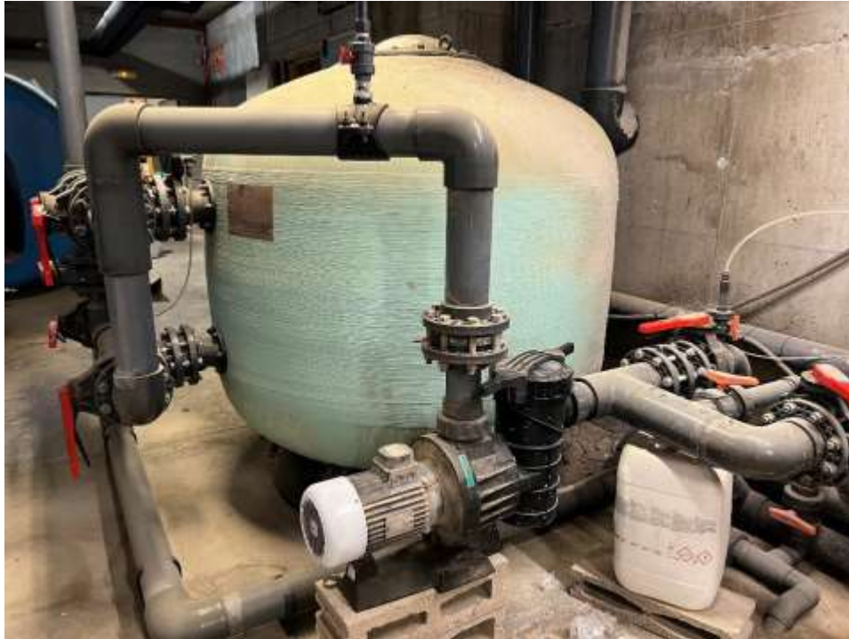
Foto.- Bomba centrífuga equip de filtratge F-1
