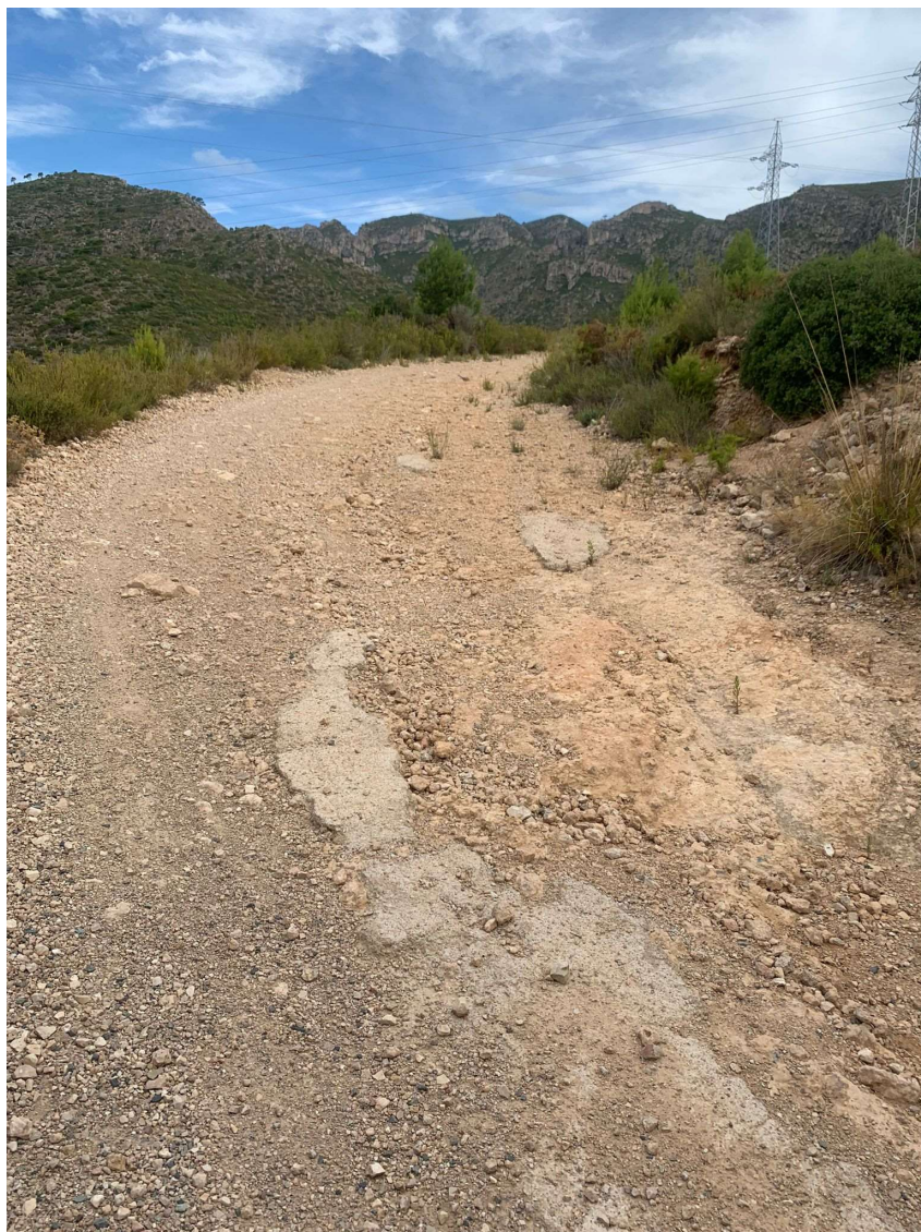
Fotografia 5 - Correspon al tram 5 de la continuació del camí del Racó del Marfull a la Porrassa, té una llargada de 409m i s'ha d'aportar terres i de pavimentar.
