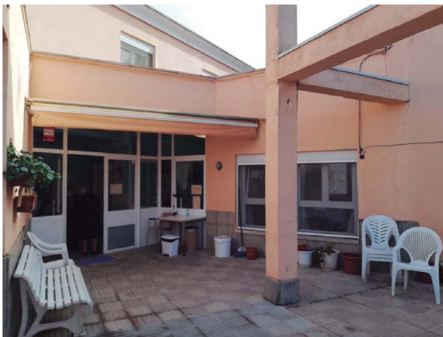
Vista 02 coberta a nivell de planta primera, porta d'accés a residència
