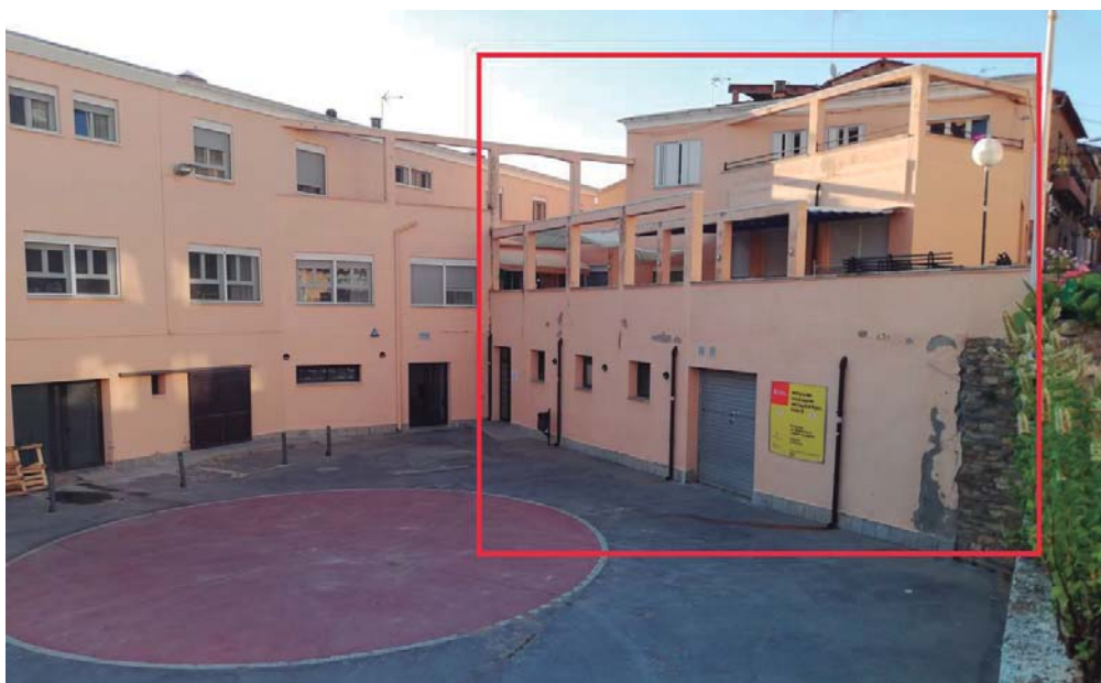
Àmbit de façanes on s'actuarà en les fusteries exteriors
