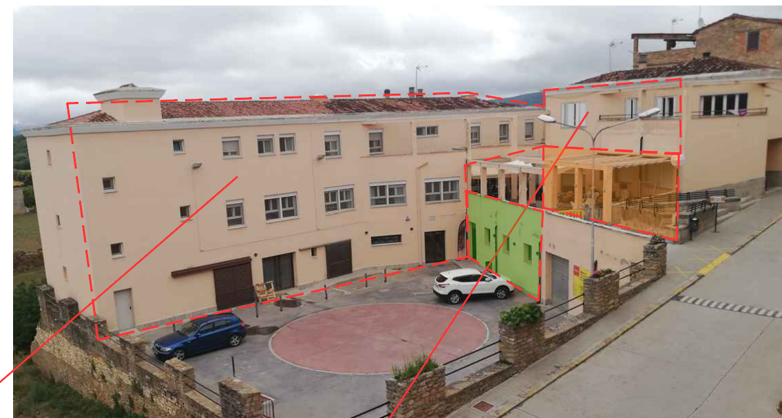
VISTA ACTUAL EN PERSPECTIVA DE LA RESIDÈNCIA DES DEL C/ LA FONT
