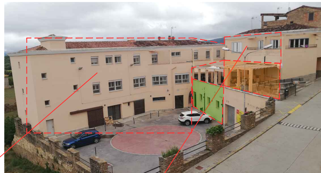
VISTA ACTUAL EN PERSPECTIVA DE LA RESIDÈNCIA DES DEL C/ LA FONT
