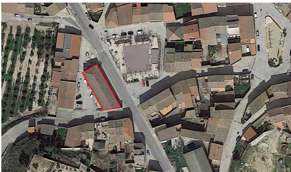
Il·lustració 1: Ubicació dels equips de captació solar sobre la coberta de l'ajuntament d'Alfés.
