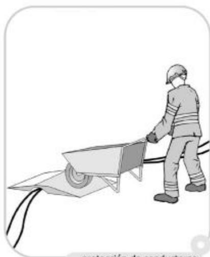
protección de conductores
