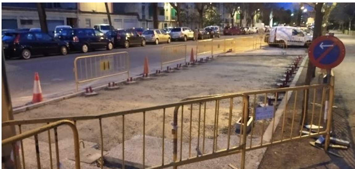
Platines anivellades i perfectament ancorades pendent de reposar el paviment
