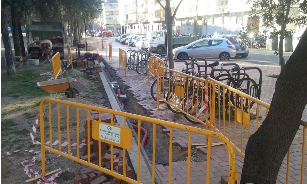
Imatge general de l'obra civil d'una estació en plena execució. Particularitats: cal adaptació de l'obra a la ubicació de cada estació.
