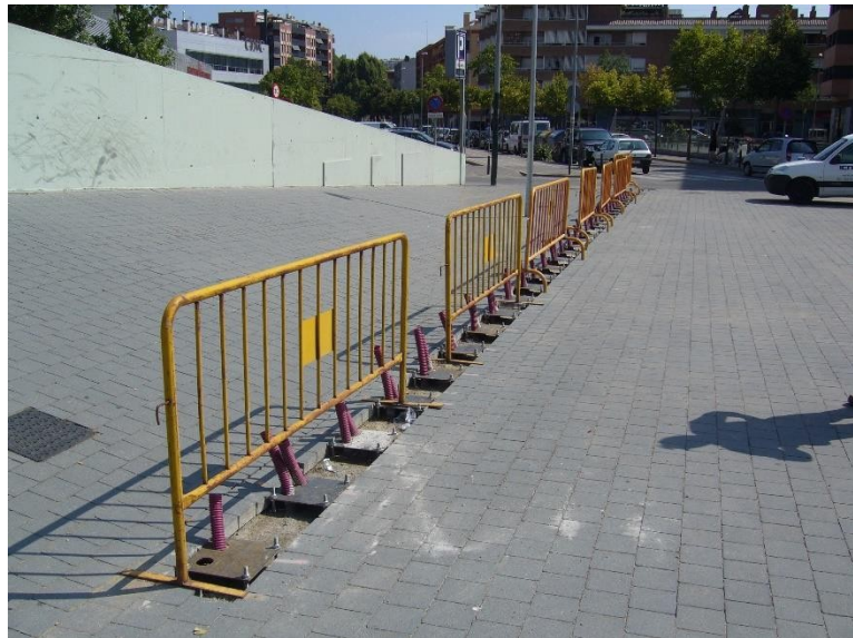
A l'esquerra imatge de platines perfectament anivellades, ancorades i adaptades als panots de la vorera. A la dreta platines anivellades i ancorades pendent de col·locar el paviment final.
