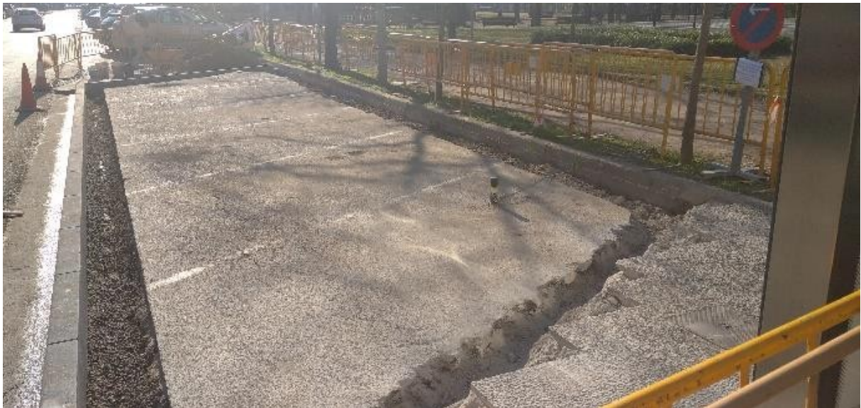
Execució de la rasa
