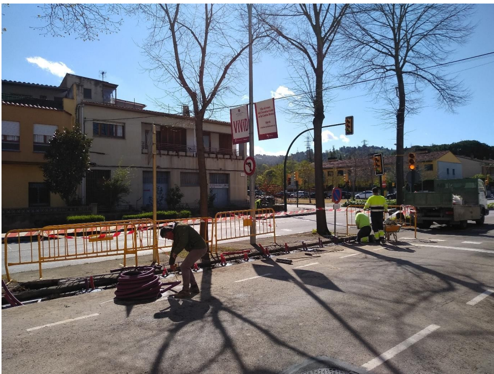
Imatge general de l'obra civil d'una estació en plena execució
