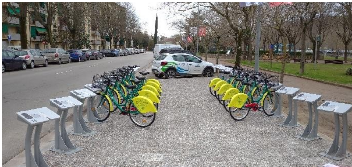
Estació executada, amb els peus d'aparcament muntats per TMG a sobre les platines. Si les platines no estan ben anivellades l'ancoratge de les bicicletes al peu d'aparcament dona problemes i caldrà arreglar-ho per compte de l'adjudicatària.
