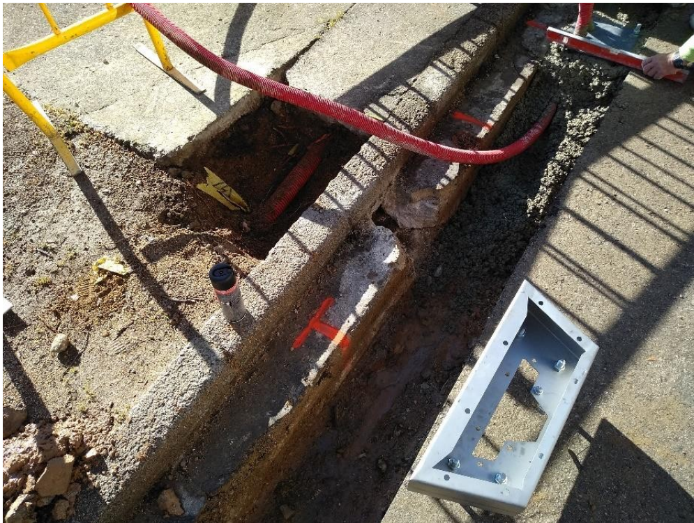
Imatge d'una instal·lació de Girocleta sobre quitrà on s'aprecia la platina del tòtem
