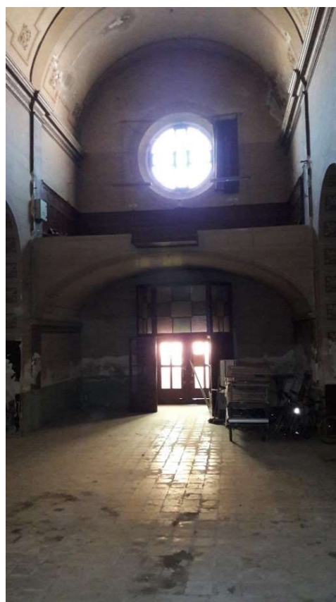
Vista interior de la façana principal
