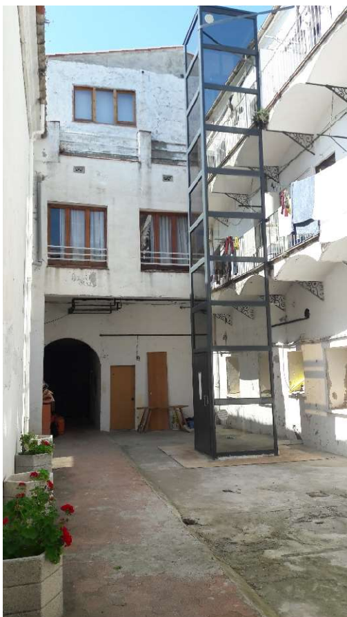
Vista del pati interior– a enderrocar
