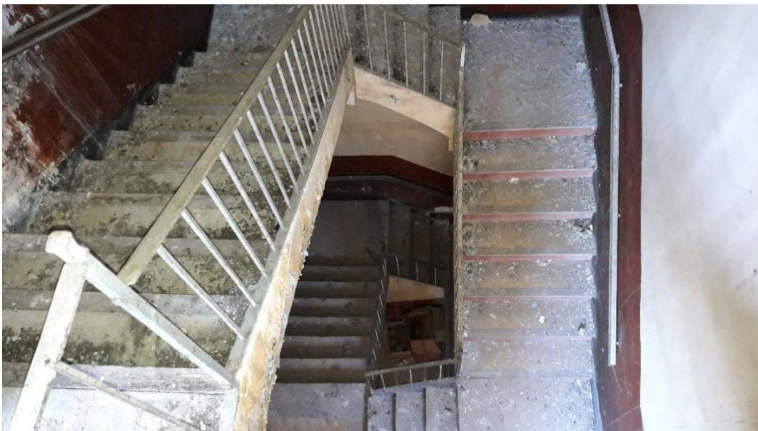
Vista del nucli de comunicacions del convent – a enderrocar
