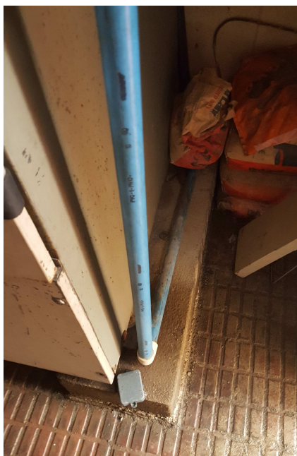
10. Bancada recolzament màquina actual
