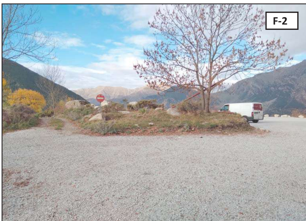
Fotografies 1 i 2: Detall de la zona on es realitza els assaigs i on es preveu emplaçar la nova construcció.
