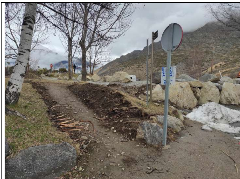
Accés peatonal des del Pla de l'Ermite
