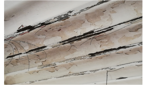
DETALL DE L'ESTAT ACTUAL DE LES BIGUES DEL SOSTRE DE PLANTA SEGONA
