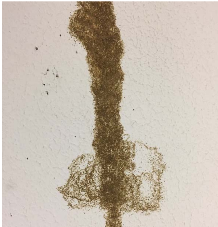
Restes de presència de termites.
