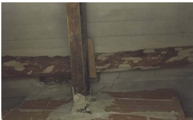
Reforç estructural metàl·lic fet anteriorment.
