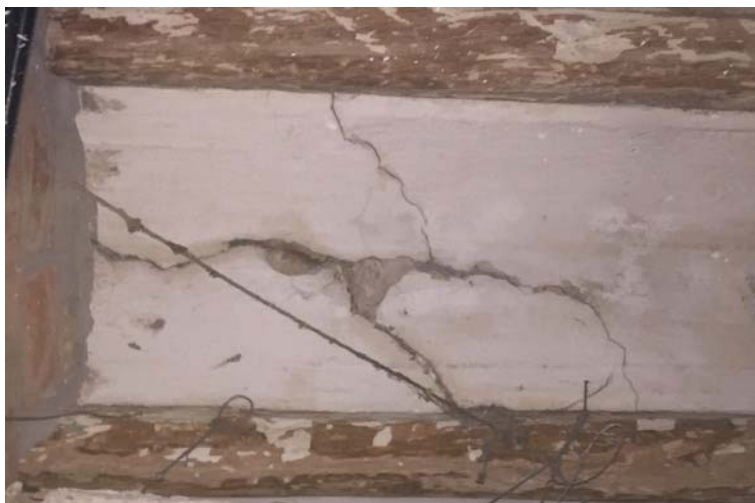
Esquerdes a l'entrebogat a diferents punts de la teulada.
