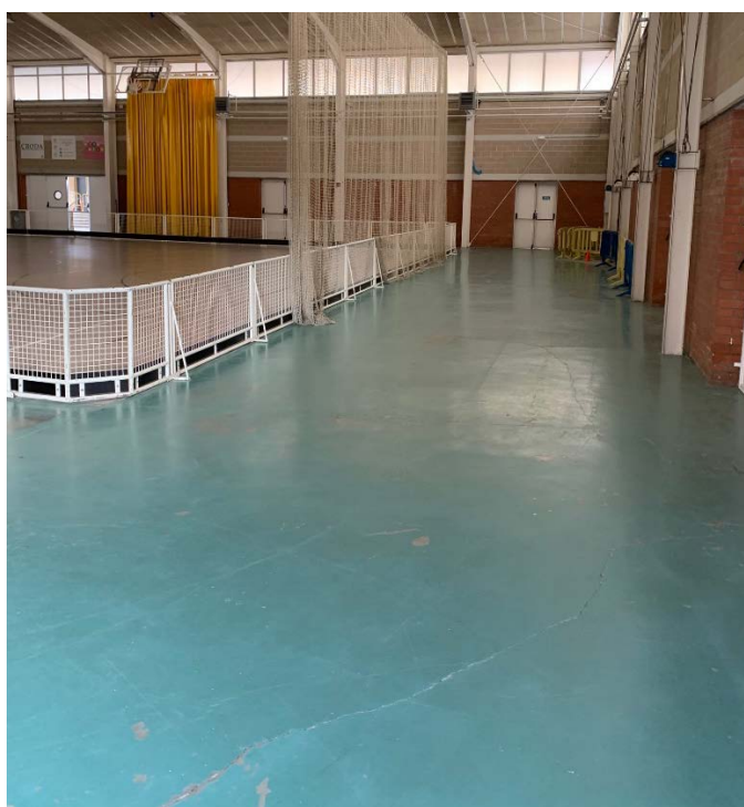
Imatges 01 i 02: vista general de la pista i del perímetre
