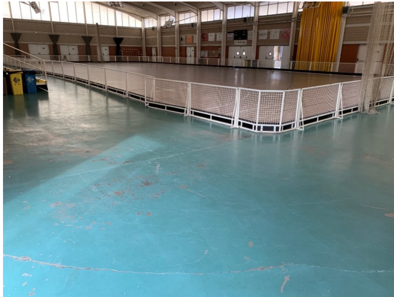
Fotografia 3.1: Vista de la pista.
