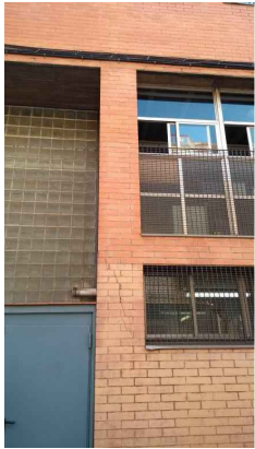
Vista actuació 3B
