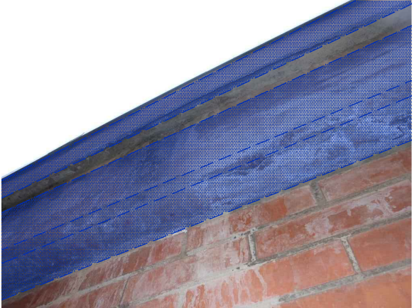
Vista de la jàssera situada al pati de la planta segona. Reparació de la canal situada sobre la jàssera
