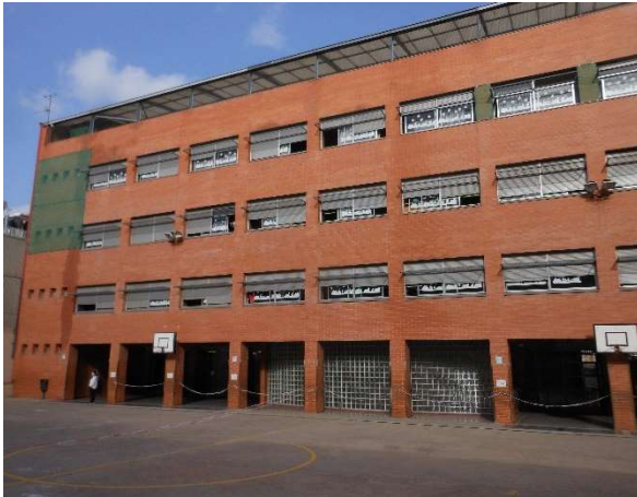
Vistes de la façana del pati interior
