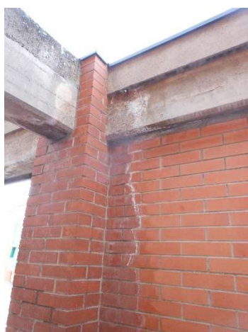
Pati P3 façana Avda. dels Banús
