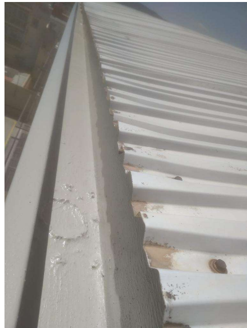
Vista de la seva reparació/tractament
