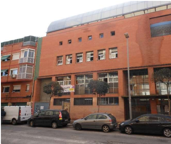
Vistes de la façana de l'Avinguda dels Banús
