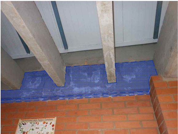
Vista de la jàssera situada a l'aula de la planta segona
