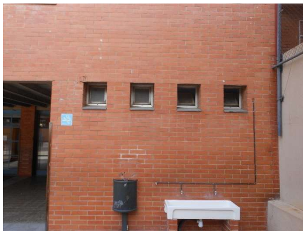
Costat dret façana pati interior
