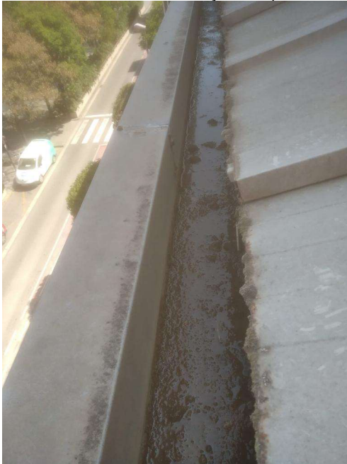
Estat inicial de la canal de la façana de l'Avda. dels Banús
