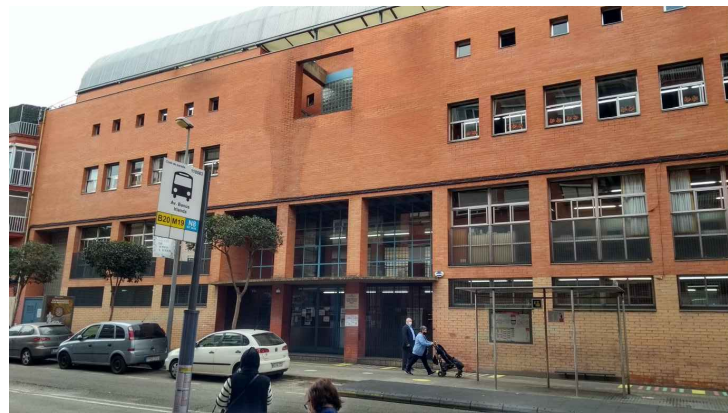
Actuació 4. Vista general de la façana de l'Avinguda dels Banús.
