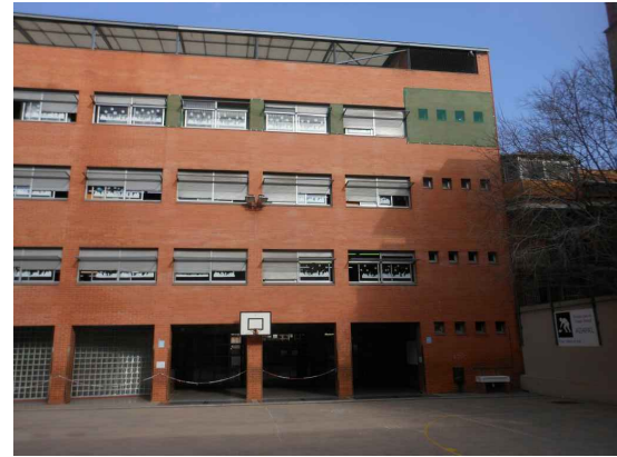
Actuació 3I. Vista general
