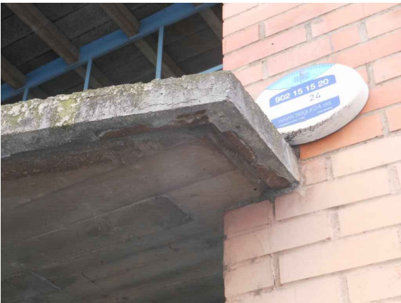
Detall de la cantonada dreta.
