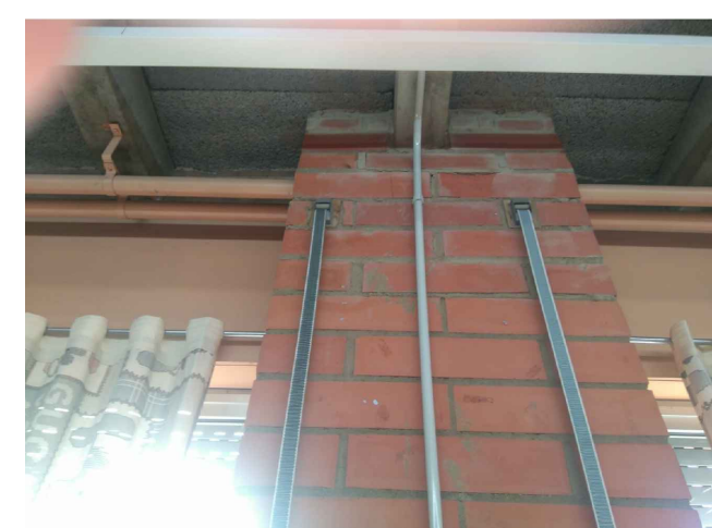
Vista dels "pitxolins" desenganxats a punt de despenjament.
