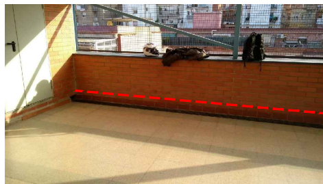
Actuació 5A. Vista més propera de la zona a segellar
