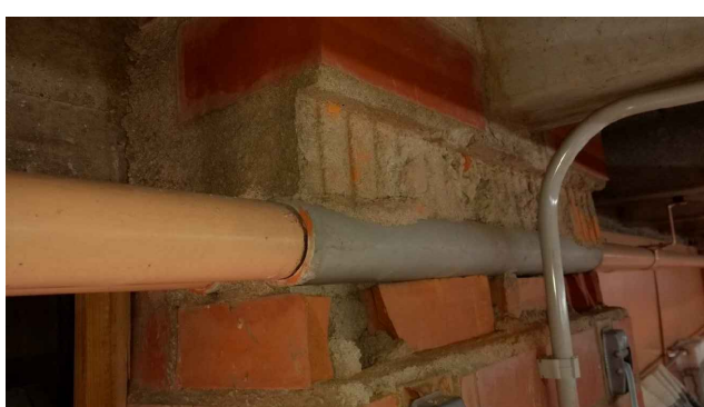
Vista dels "pitxolins" desenganxats a punt de despenjament.
