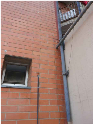
Vista actuació 3I
