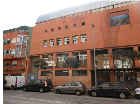
Actuació 3J. Vista general
