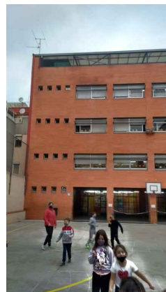
Actuació 4. Vista general de la façana del pati interior
