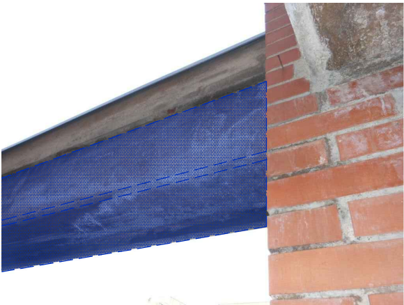
Vista de la jàssera situada al pati de la planta segona
