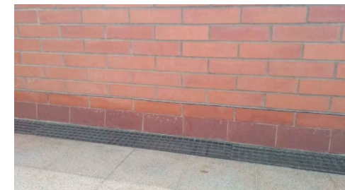
Actuació 5A. Vista en detall de la zona a segellar
