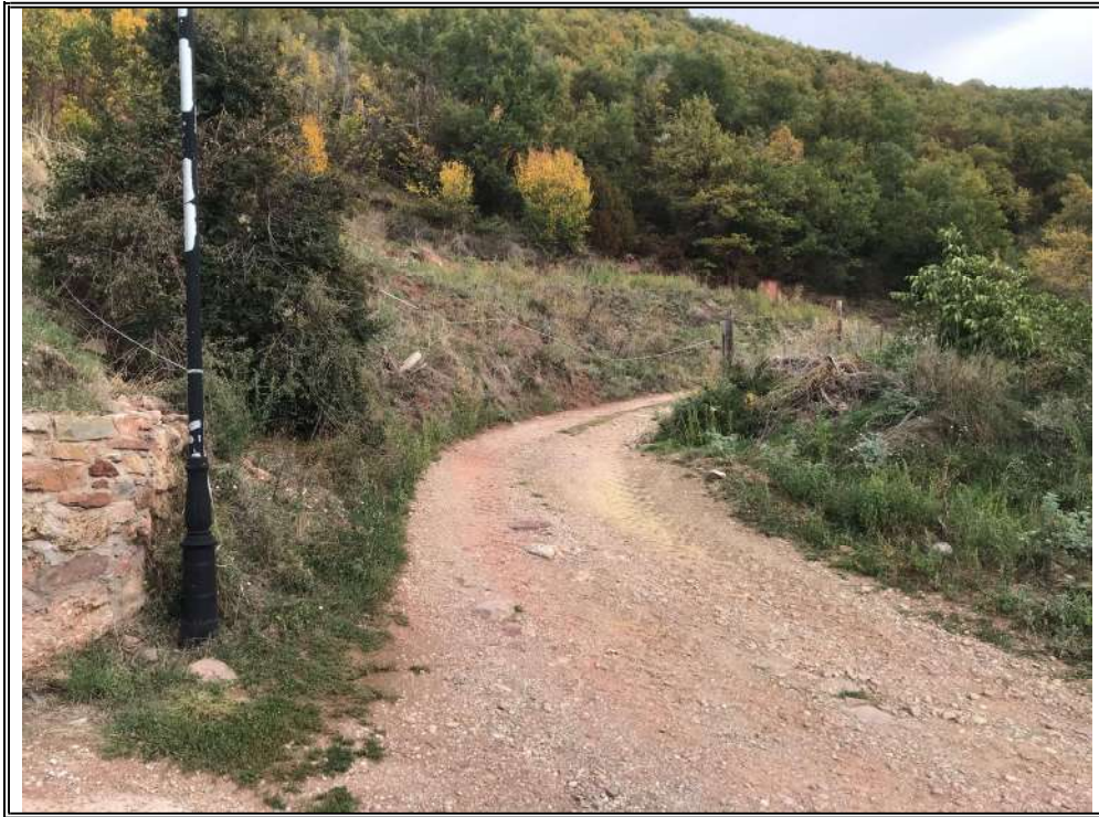
Figura 4. Vista del tram de l'accés d'Igüerri on cal construir el paviment de formigó. Desembre 2022.
