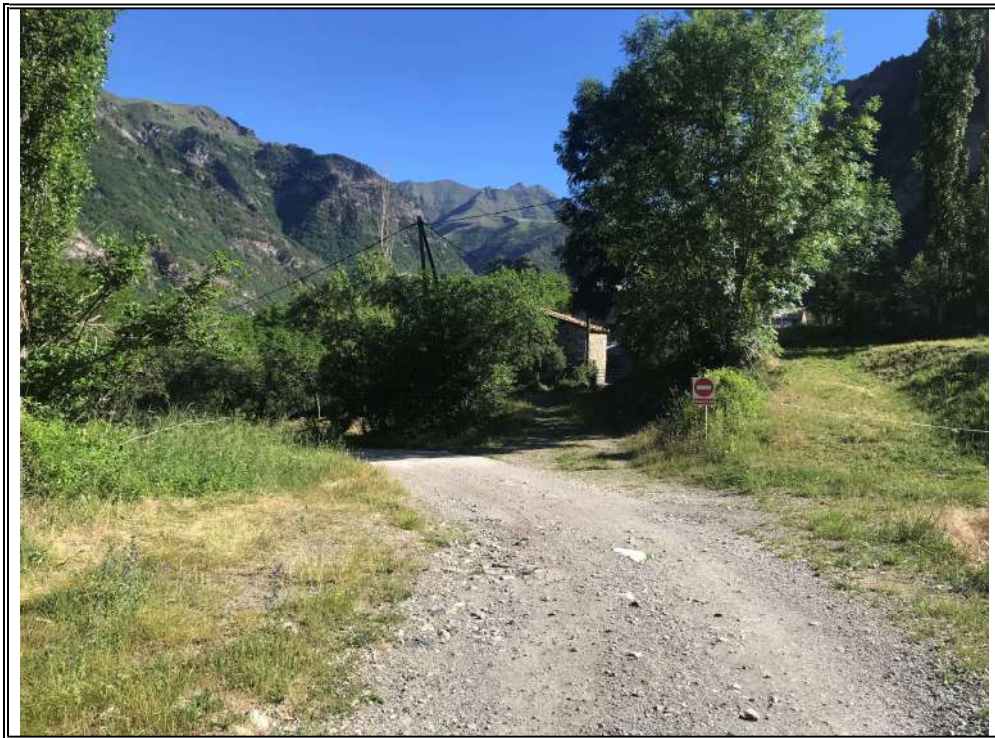
Figura 5. Vista del tram de l'accés de Cierco i Artiga on cal construir el paviment de formigó. Desembre 2022. Desembre 2022.
