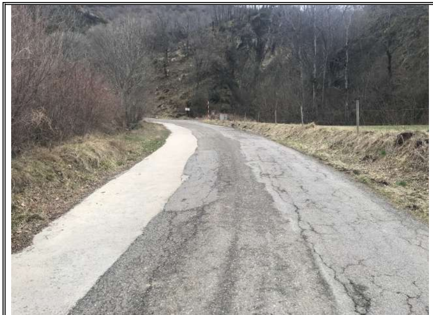
Figura 10. Vista actual de trams on cal realitzar el paviment aglomerat en calent: accés de Durro. Desembre 2022
